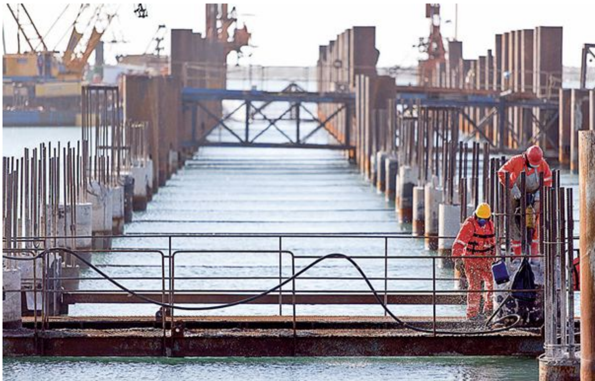
Estruturas em contato direto com a água do mar exigem maior cuidado na especificação do concreto e na proteção das armaduras, pois estão sujeitas a condições mais agressivas, já que as ações do ar, da água e dos sais ocorrem em intervalos cíclicos junto com processos físicos de abrasão. Foto mostra obra do Porto de Fortaleza
