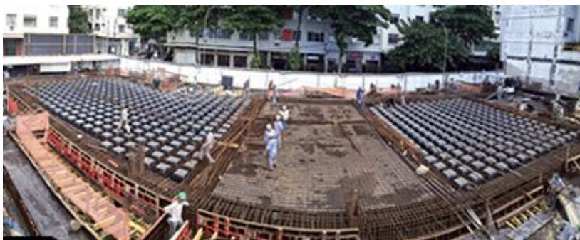
Preparação para concretagem da laje do térreo do MIS Copacabana
