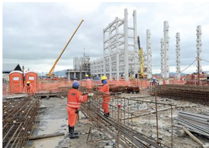
Obra do Complexo Petroquímico do Rio de Janeiro da Petrobras, em Itaboraí. Algumas estruturas de concreto em refinarias localizadas em regiões litorâneas são mais suscetíveis ao desenvolvimento de processos corrosivos, pois estão expostas à ação de agentes químicos da área de produção e à ação da névoa salina
