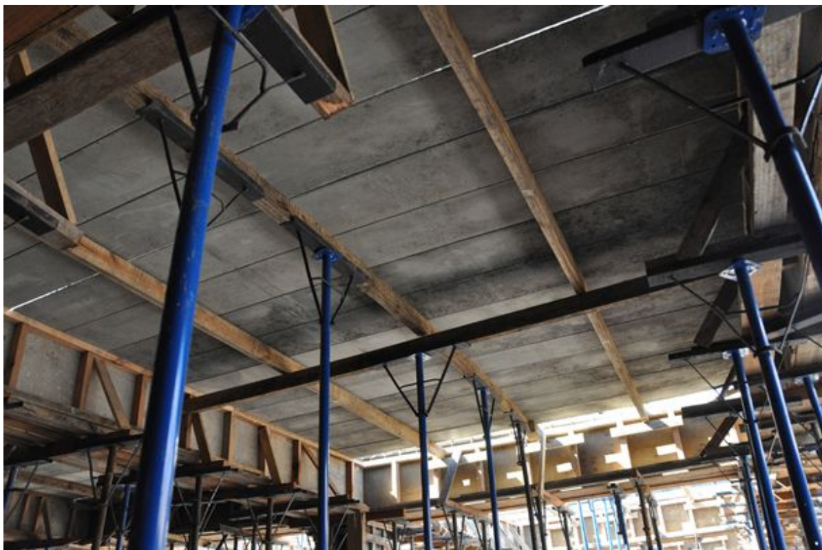
O uso das pré-lajes de tabuleiro reduz a necessidade de escoras de cimbramento e o tempo de permanência durante a cura do concreto
