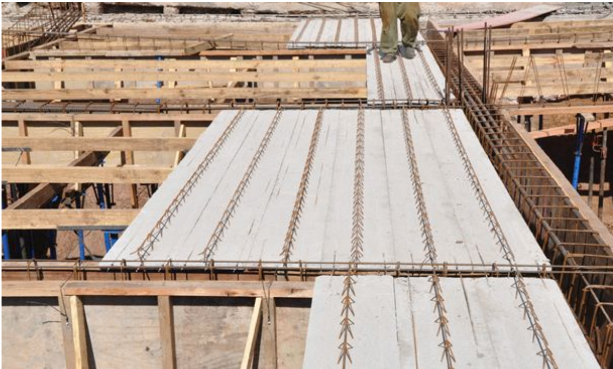
Em diferentes tamanhos, as pré-lajes permitem agilidade de instalação no canteiro também para obras de pequeno porte.
