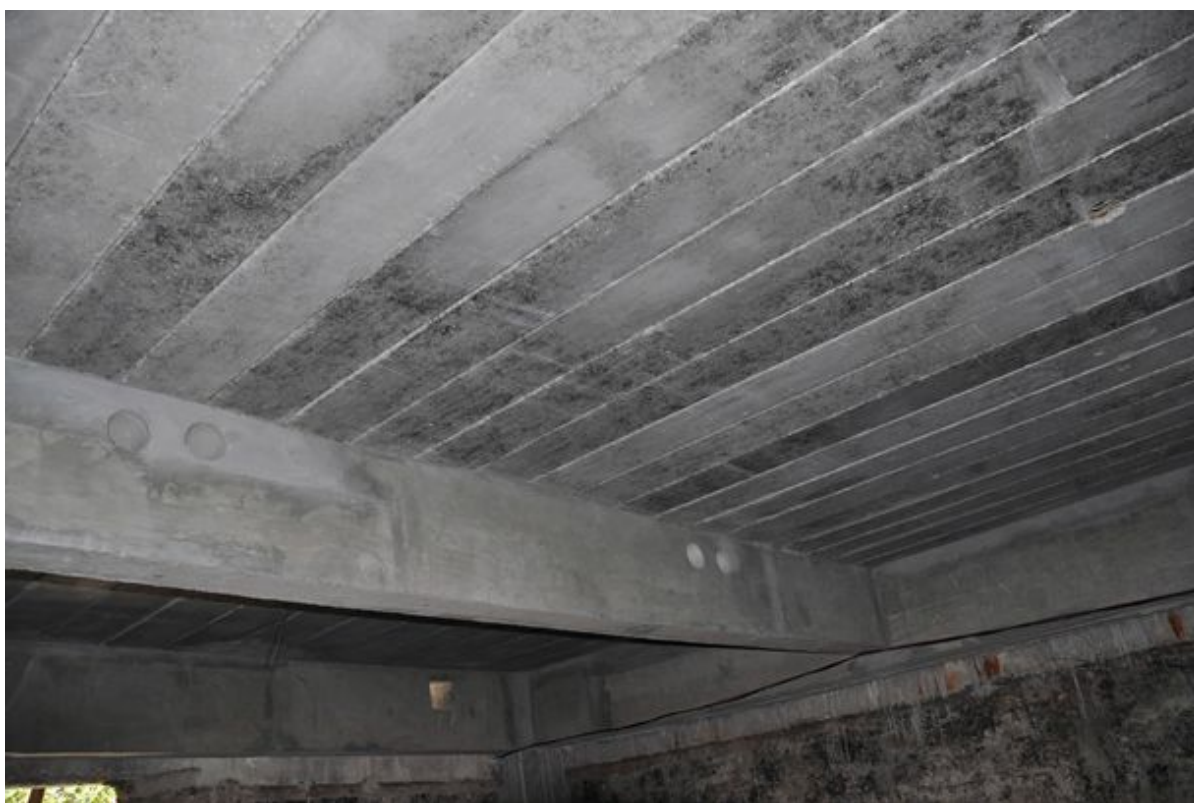
As pré-lajes dispensam o uso das tradicionais fôrmas e pranchões de compensado. Assim, diminui-se o tempo de montagem do cimbramento. Além disso, o acabamento na parte inferior é mais regular e facilita o revestimento
