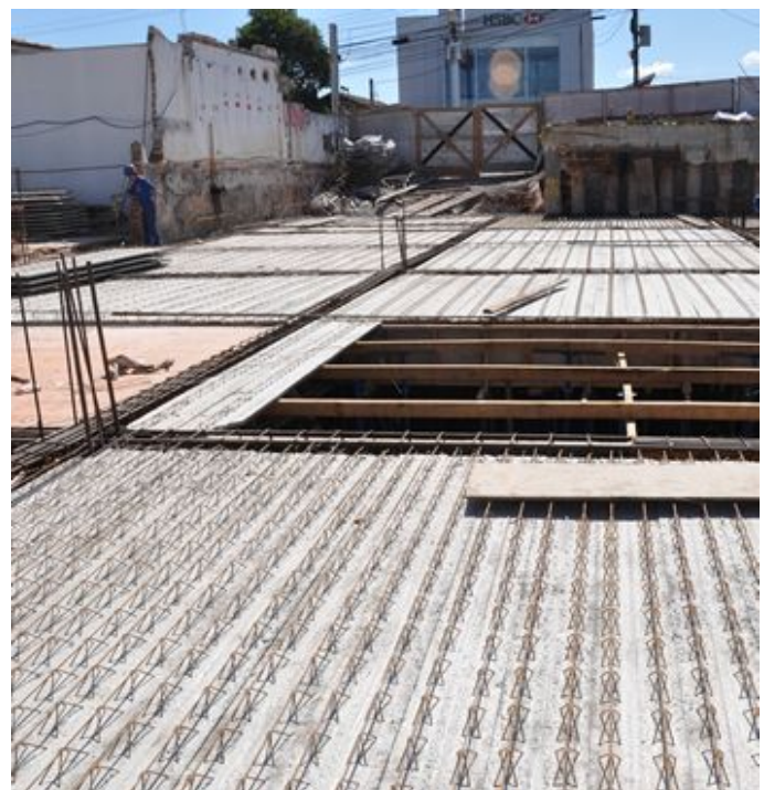
Com a instalação modular, fica mais fácil trabalhar as aberturas
