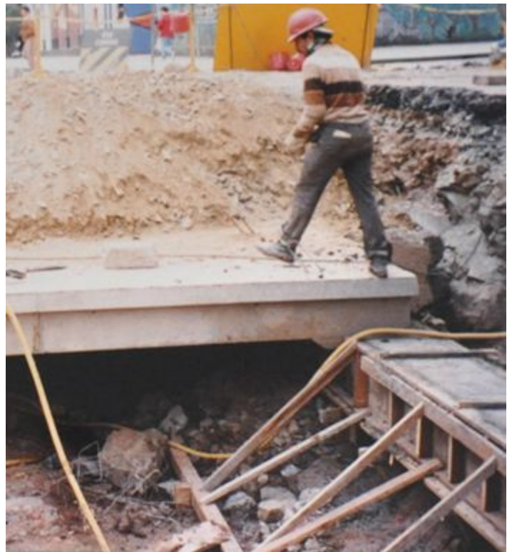
Caixas de escada, fiação, ou shafts de passagem de encanamento devem ser previstos antes da concretagem da laje. Assim, dispensam-se os furos posteriores.
