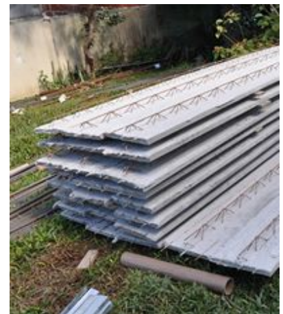
Em diferentes tamanhos, as pré-lajes permitem agilidade de instalação no canteiro também para obras de pequeno porte.
