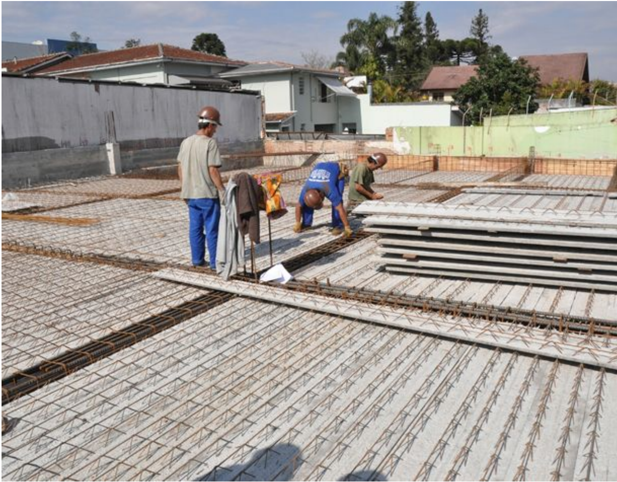
Com módulos pequenos, as pré-lajes podem ser manuseadas pela própria equipe. Isso permite que a técnica possa ser empregada em obras de qualquer porte, inclusive residenciais
