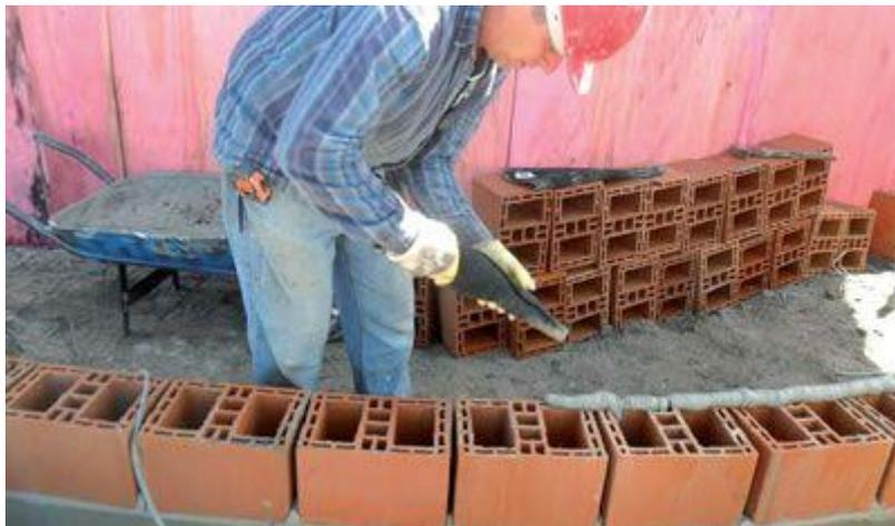
Segundo a empresa, a colher, além de aumentar o desperdício, acaba prejudicando as instalações elétricas devido ao excesso de argamassa que fica dentro dos blocos.
