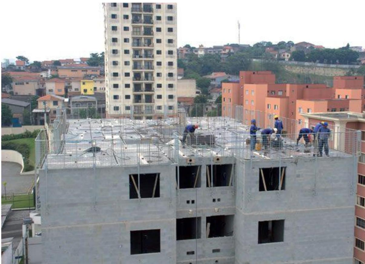
Por dispensar a concretagem de elementos estruturais in loco, como pilares, a alvenaria estrutural é capaz de, em alguns casos, aumentar a velocidade de execução. Afinal, os blocos atuam como elementos de vedação e estrutura.
