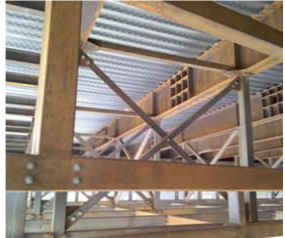
Indicado para compor um conjunto estrutural com vigas de aço, o steel deck dispensa parcial ou totalmente os escoramentos, reduzindo custos com aluguel, indenizações, montagem e desmontagem de equipamentos e com mão de obra
