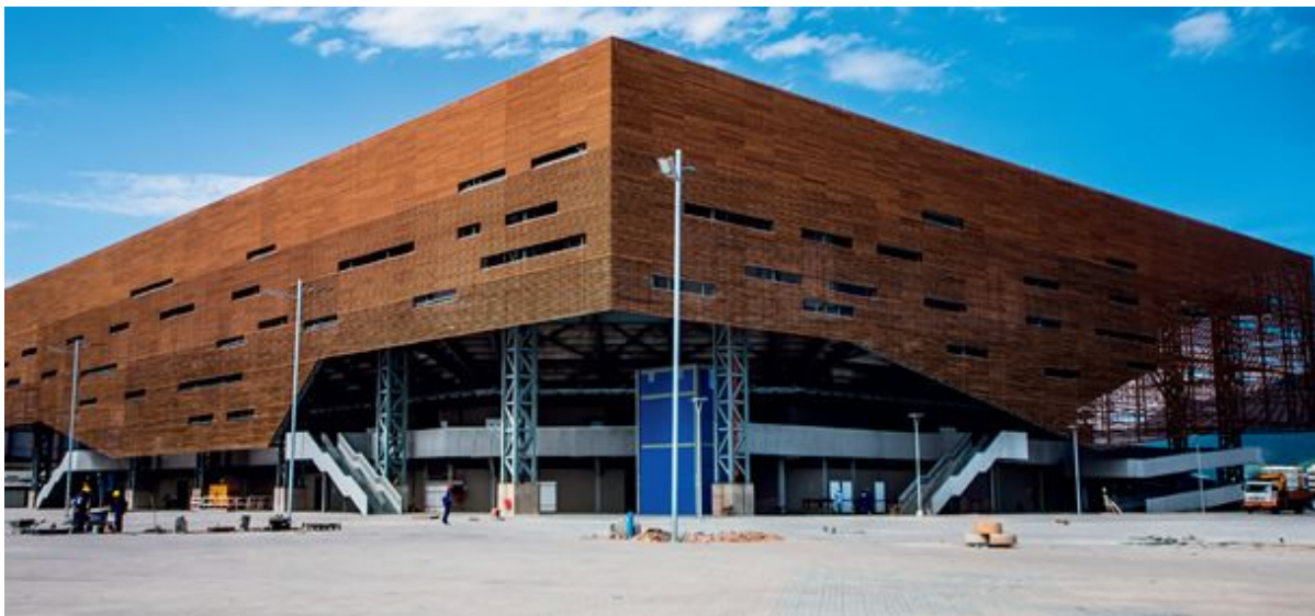
Com ligações parafusadas, a Arena do Futuro, que receberá os jogos de handebol na Olimpíada 2016, será posteriormente desmontada e reconstruída como escolas públicas na cidade do Rio de Janeiro
