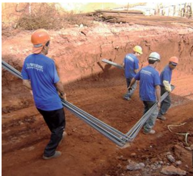
Avalie se houve avarias no transporte. As barras devem estar retas, sem ferrugem ou sinais de corrosão
