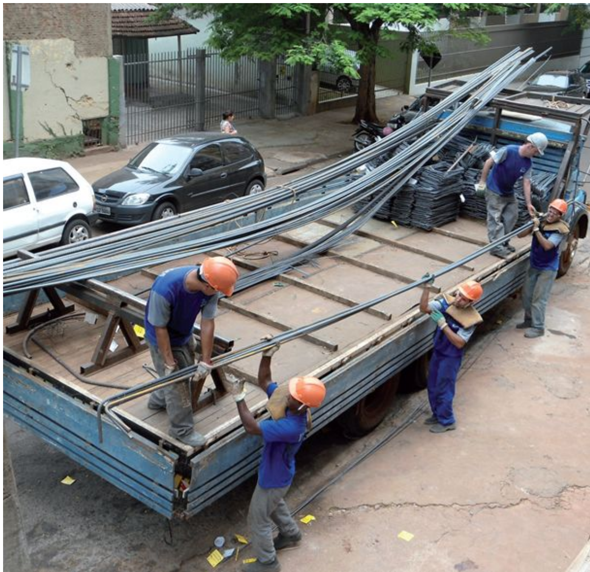
Avalie se houve avarias no transporte. As barras devem estar retas, sem ferrugem ou sinais de corrosão
