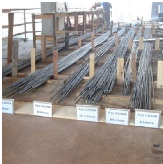
Avalie se houve avarias no transporte. As barras devem estar retas, sem ferrugem ou sinais de corrosão
