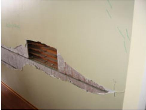
Os problemas resultantes do reescoramento mal-executado são invisíveis a olho nu. Porém, a deformação exagerada da estrutura pode se manifestar em patologias nas alvenarias
