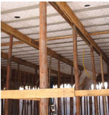
**Tronco:** sistema mais rudimentar, geralmente se utilizam troncos de eucalipto de Ø 10 cm. O material é heterogêneo, e as peças diferentes entre si. O ajuste de altura deve ser feito com cunhas de madeira.
