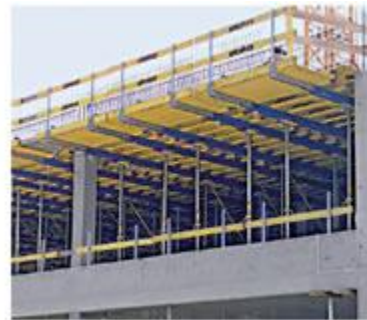
3. Colocação das mesas na posição de concretagem
