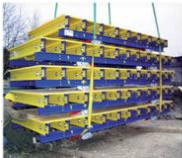
1. Chegada das mesas à obra
