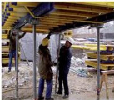
2. Montagem das escoras
