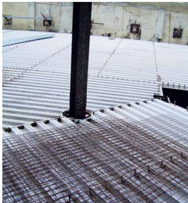
Sistema se caracteriza por uma telha de aço galvanizado em formato trapezoidal que funciona como fôrma durante a concretagem e como armadura positiva durante as cargas de serviço
