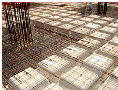
Disposição das fôrmas e da ferragem
