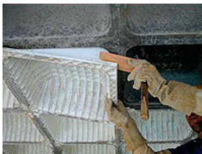
Não forçar os cantos da fôrma
