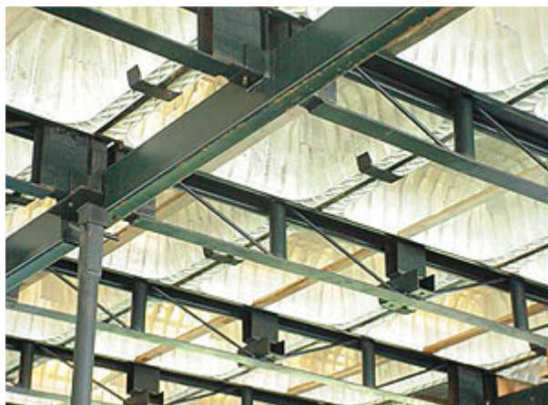
Aplicação na laje
