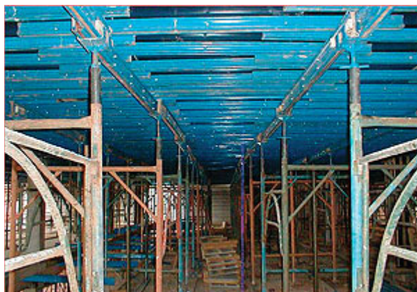
Aplicação na laje
