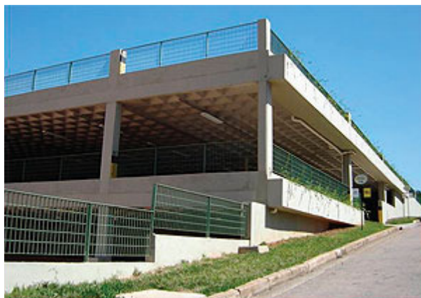
Aplicação na laje
