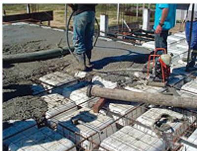
Bombeamento do concreto
