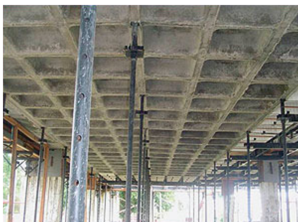
Aplicação na laje
