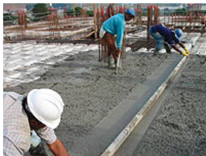
Regularização da superfície da laje
