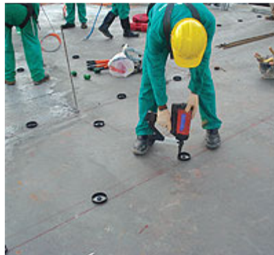
Foto 6 - Instalação dos espaçadores
