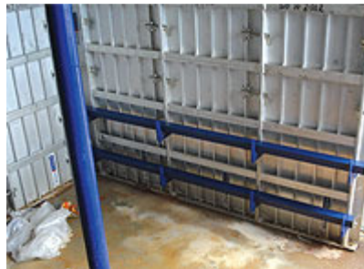
Foto 12 - Montagem de alinhadores
