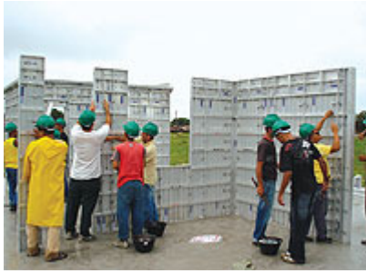
Foto 9 - Montagem das fôrmas
