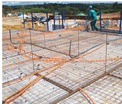
Foto 8 - Instalação da tubulações hidráulicas e elétricas
