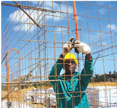
Foto 7 - Instalação das telas soldadas
