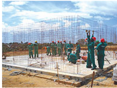
Foto 10 - Colocação das telas de aço
