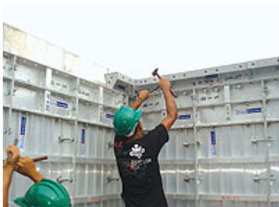
Foto 13 - Montagem de quinas
