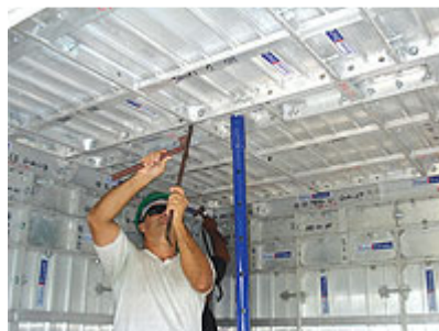
Foto 14 - Montagem da laje
