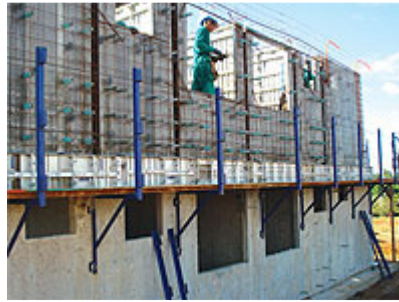
Foto 16 - Plataforma de trabalho
