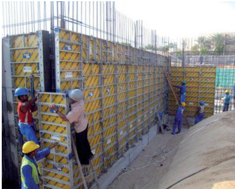
O peso e a facilidade de manuseio dos painéis são fatores que influenciam diretamente a produtividade no canteiro
