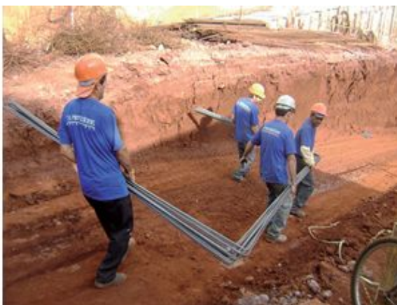
Figura 8 - Estoque de barras retas em canteiro de obras Figura 9 - Descarga manual de aço
