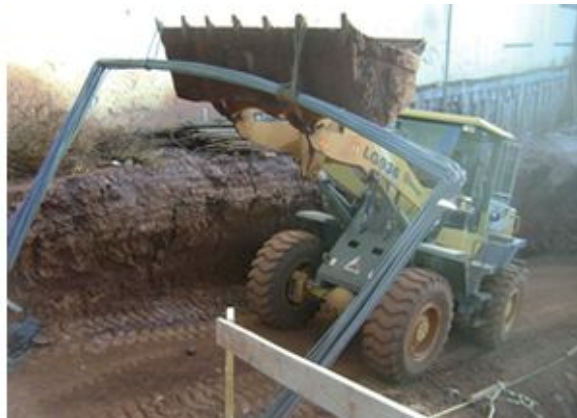
Figura 11 - Descarga de aço com pá-carregadeira
