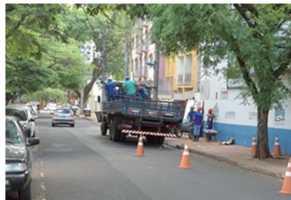
Figura 13 - Interdição da via para descarga de aço
