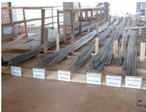
Figura 8 - Estoque de barras retas em canteiro de obras Figura 9 - Descarga manual de aço
