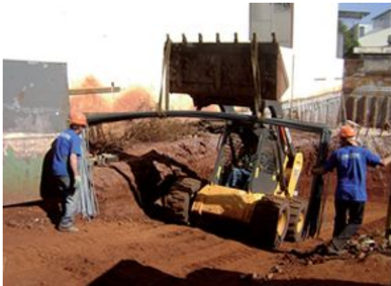
Figura 10 - Descarga de aço com minipá-carregadeira
