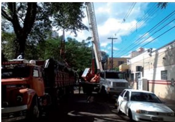
Figura 12 - Descarga de aço com guindaste
