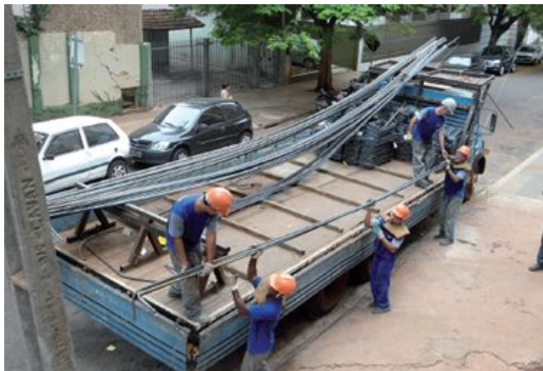
Figura 5 - Recebimento de aço cortado e dobrado de fábrica em canteiro de obras
