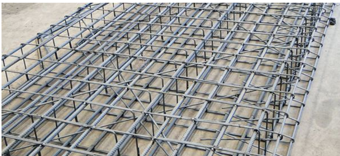
Maior precisão e menores desperdícios são vantagens das armações preparadas em fábrica
