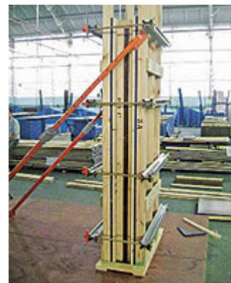
Foto 2 - Montagem dos painéis de pilares
