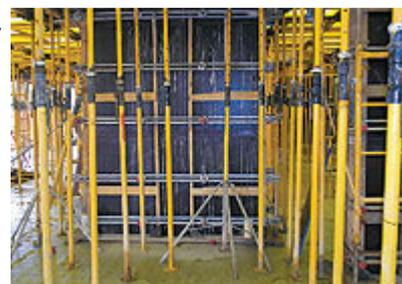
Foto 8 - Sistema de fôrma com cimbramento metálico
