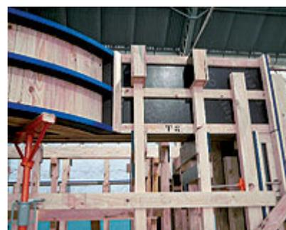
Foto 4 - Fundo de vigas e lajes limitam o uso dos garfos de madeira
