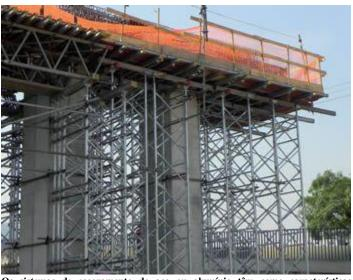
principalmente, por escoras Os sistemas de escoramento de aço ou alumínio têm como características principais ajustes precisos, resistência, uniões e encaixes simples
