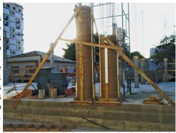
além de receberem uma As fôrmas de papelão são utilizadas basicamente em pilares de seção circular. Sua principal vantagem é ser uma fôrma autoestruturada, necessitando apenas de camada interna de papel não elementos de posicionamento e prumo
