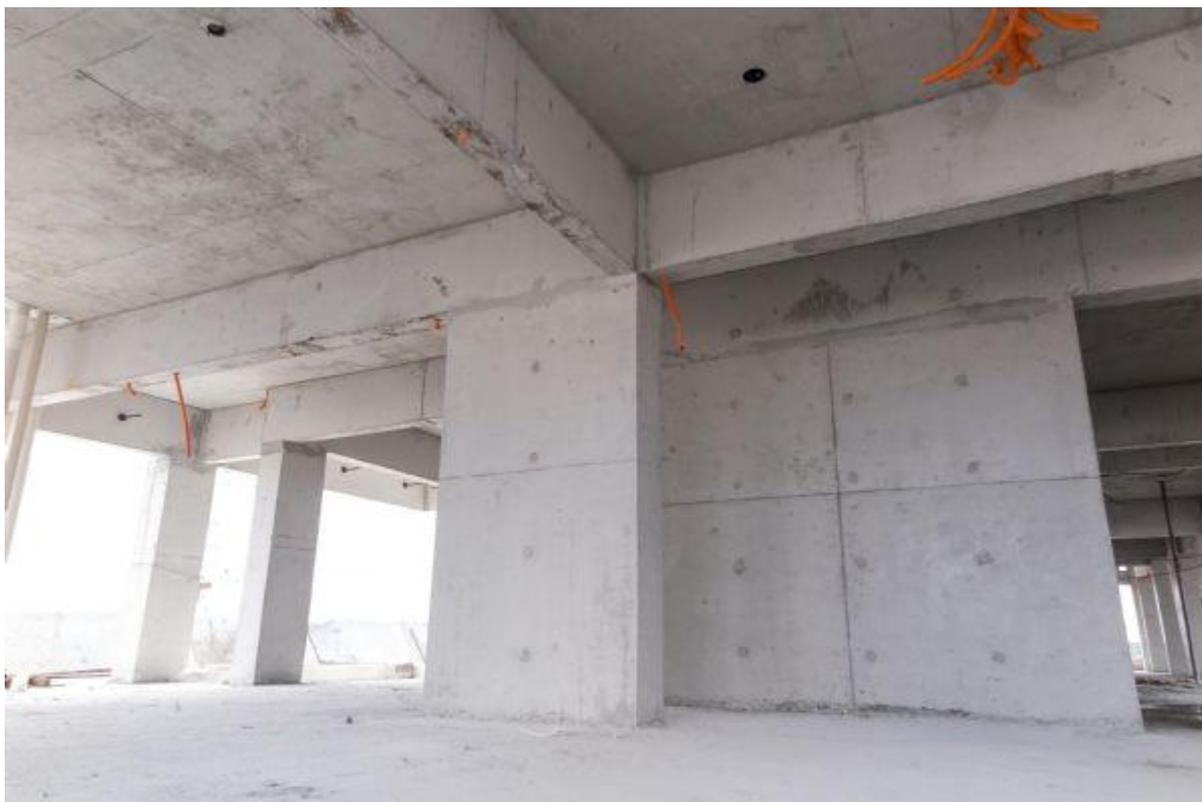
Sistema de fôrmas deve ter rigidez estrutural suficiente para que as peças concretadas não se deformem
