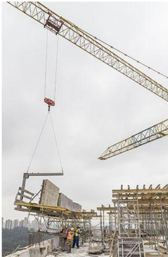
Em alguns casos, o projetista estrutural precisa se adaptar aos equipamentos existentes. Isso é comum, por exemplo, em obras com fôrmas para paredes de concreto e mesas voadoras
