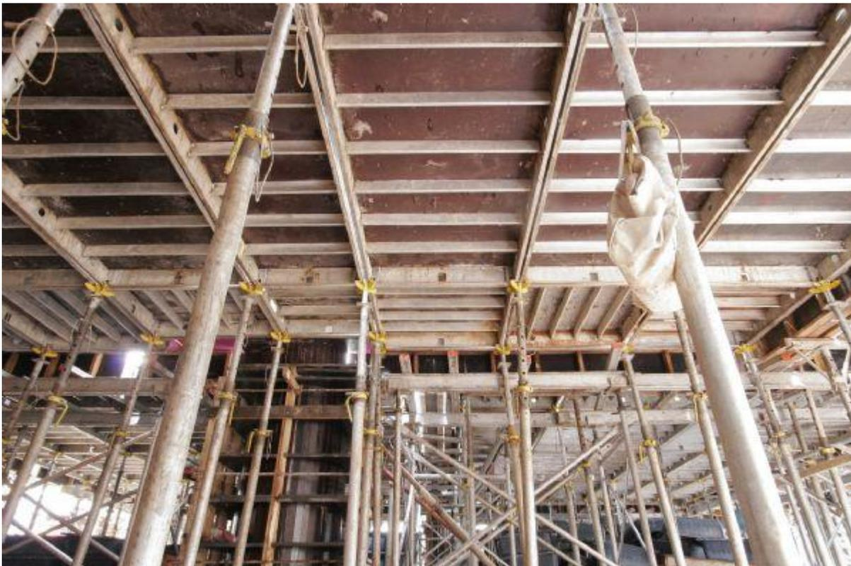
Possivelmente, o aspecto mais fundamental do processo de escolha de sistemas de fôrmas para concreto é a observância com relação à sua resistência, devendo ter rigidez estrutural suficiente para que as peças concretadas não se deformem. Outros aspectos, entretanto, também precisam ser considerados para que o sistema de fôrmas seja capaz de conciliar demandas arquitetônicas, estruturais, logísticas e relativas à produtividade almejada pela construtora.
