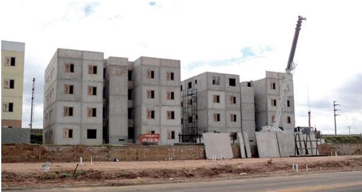
O sistema construtivo de painéis nervurados pré-fabricados de concreto (figura 1) é composto por elementos que constituem paredes e lajes de concreto armado estruturais para edificações habitacionais de até cinco pavimentos e que, por esse motivo, não podem ser demolidos total ou parcialmente.
