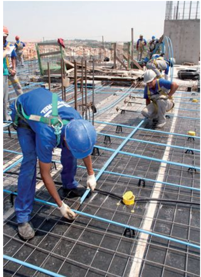
Durante o processo de montagem das cordoalhas, os operários devem saber que o posicionamento vertical dos cabos de protensão tem prioridade sobre outras instalações
