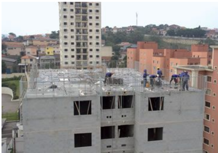
Empreendimentos de 15 ou até 20 pavimentos podem ser executados com sucesso utilizando alvenaria estrutural
