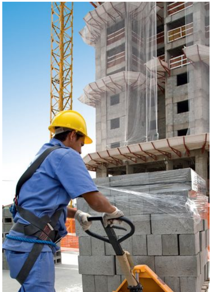
Ao lado, produzidos a partir de cimento, areia, pedrisco, pó de pedra e água, os blocos estruturais de concreto se espalham por todo o País. A resistência geralmente varia de 4,5 MPa a 16 MPa.
