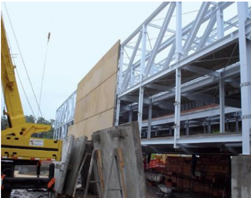
Instalação dos painéis pré-moldados exige planejamento logístico do canteiro e dos equipamentos de movimentação de cargas (gruas ou guindastes)
