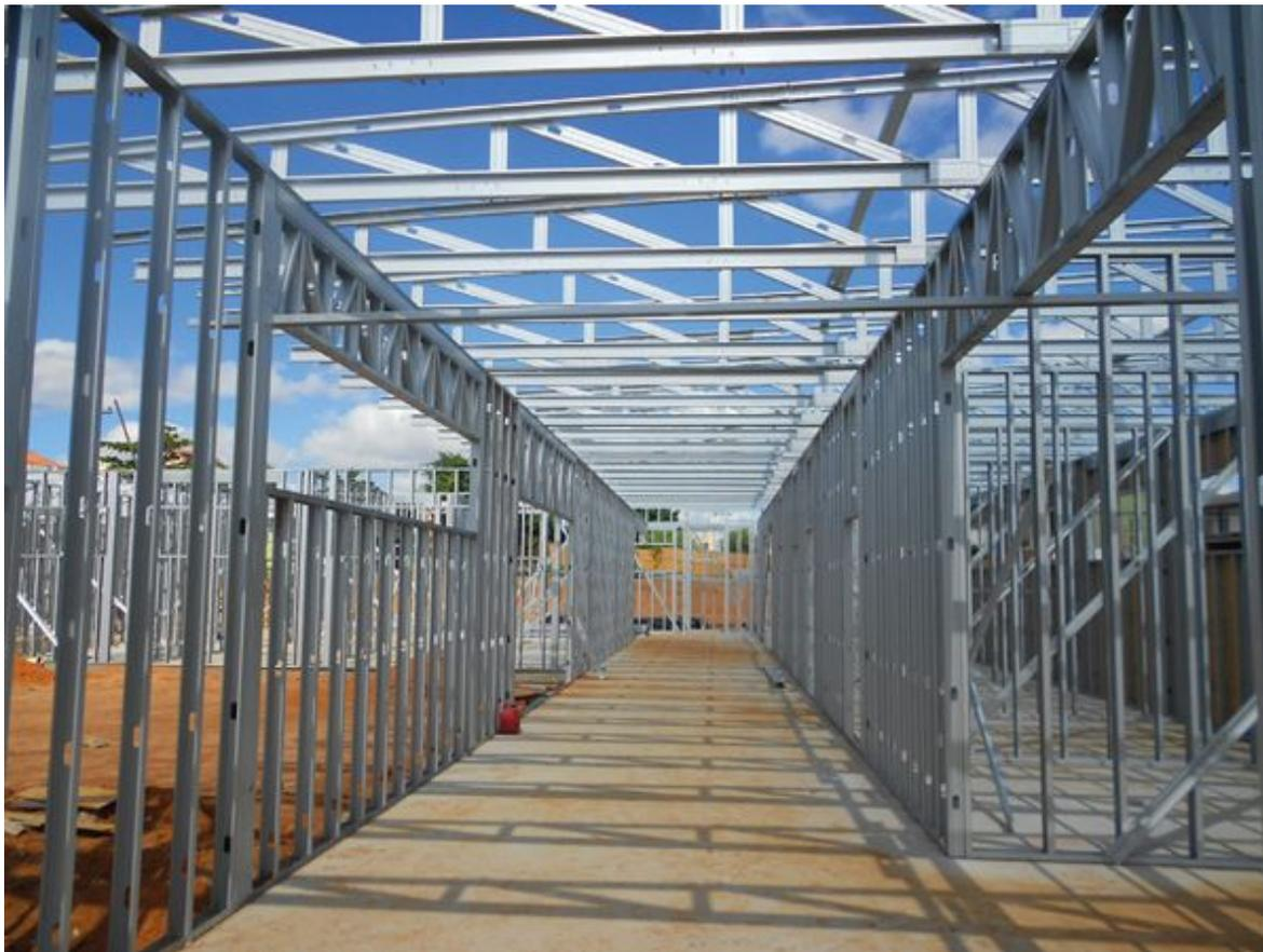
Os perfis estruturais podem ser cortados ou furados, recompondo-se a proteção contra corrosão. O espaçamento usualmente adotado entre os montantes é de 40 cm, variando conforme projeto estrutural
