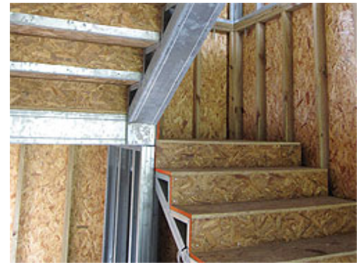
Detalhe da escada
