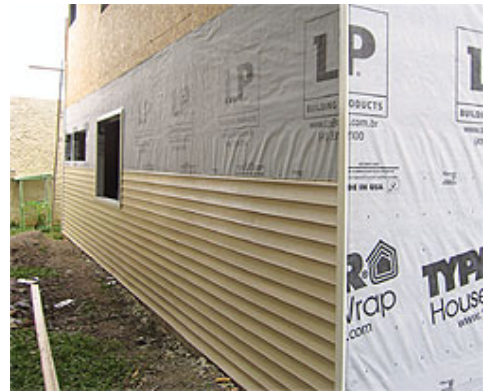
Proteção com membrana e revestimento com siding vinílico
