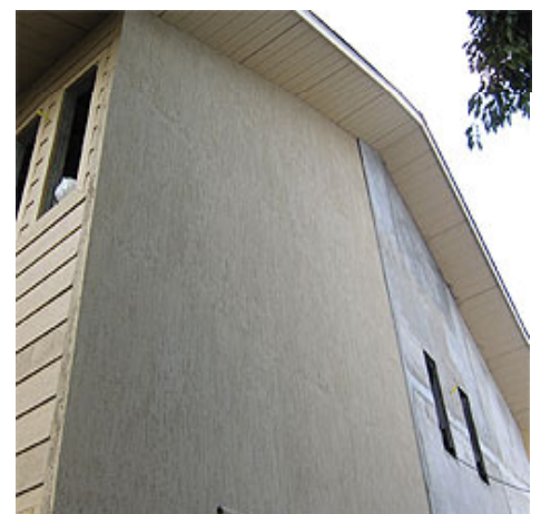
Revestimento com placa cimentícia
