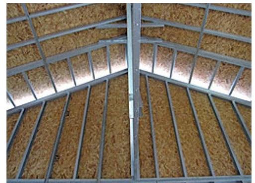
Detalhe da cobertura
