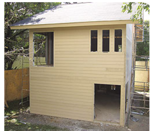
Revestimento com SmartSide
