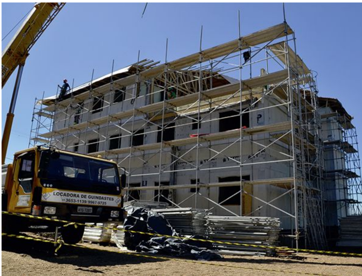
Montagem do primeiro prédio wood frame do Brasil, com tecnologia aprovada pelo Ministério das Cidades, foi realizada em 40 horas
