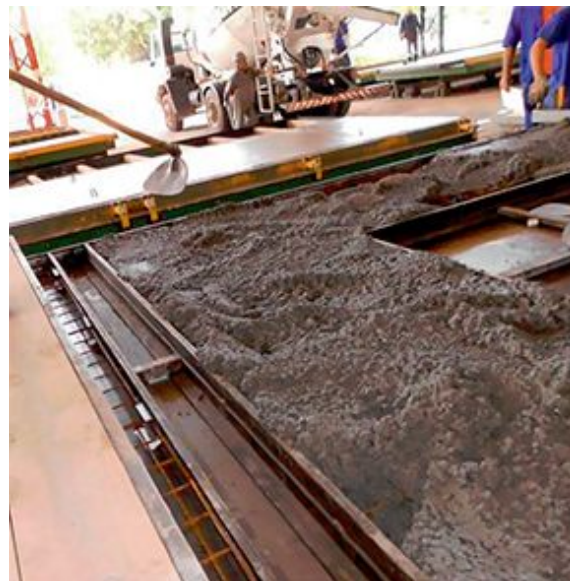
Figura 11 - Espalhamento do concreto
