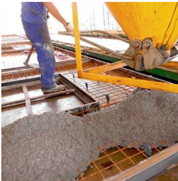
Figura 10 - Lançamento do concreto
