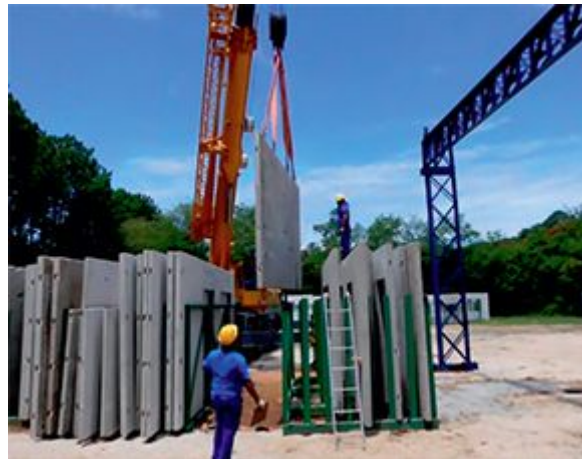
Figura 17 - Estocagem dos painéis
