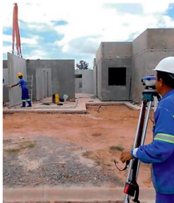
Figura 20 - Verificação do nivelamento do painel
