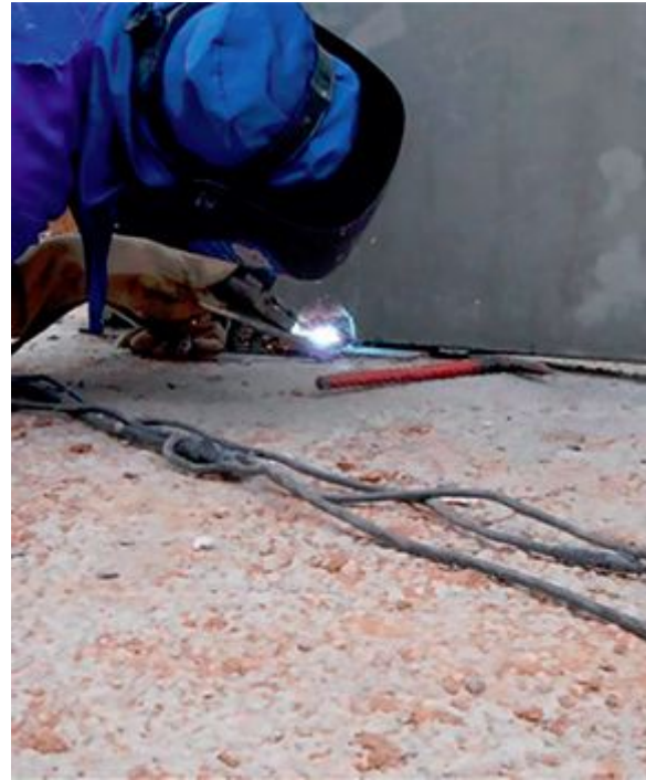
Figura 22 - Soldagem da base do painel
