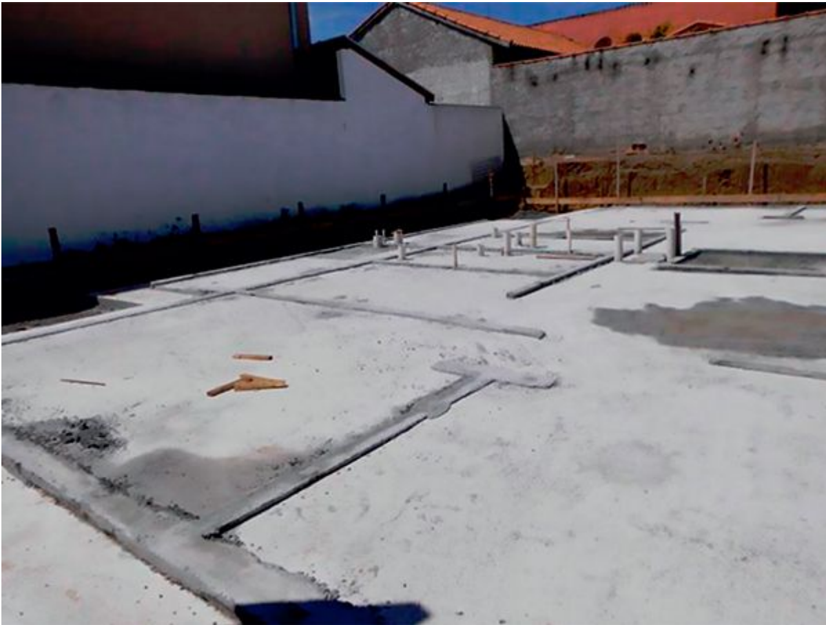
Figura 23 - Regularização do radier nas bases das paredes
