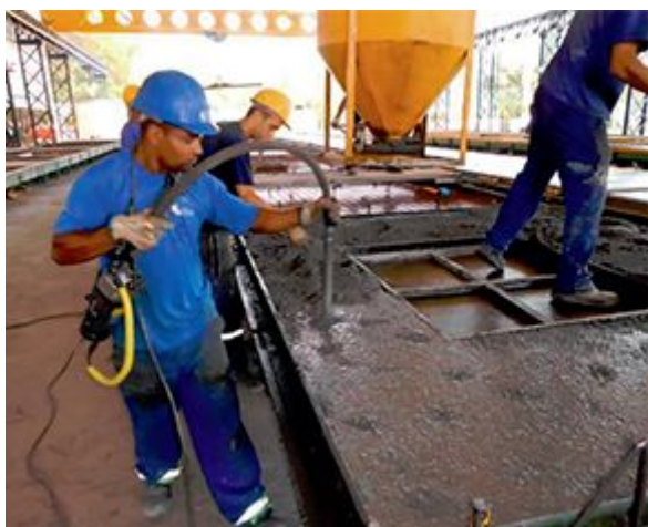
Figura 12 - Adensamento do concreto
