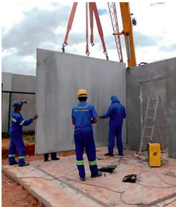
Figura 19 - Posicionamento do painel
