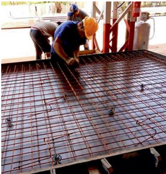
Figura 8 - Montagem da armadura
