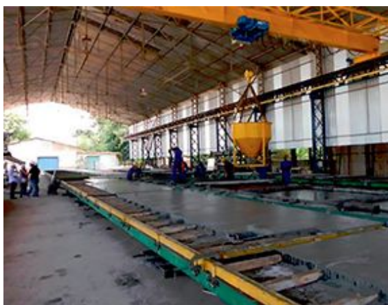
Figura 2 - Vista geral das fôrmas de aço
