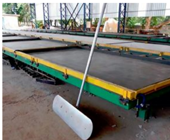
Figura 15 - Desempenadeira metálica usada no acabamento da face do painel
