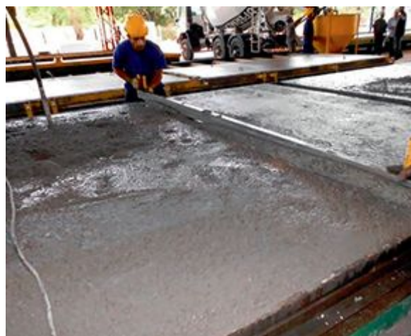
Figura 13 - Sarrafeamento do concreto
