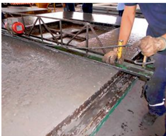
Figura 14 - Alisamento da superfície do concreto
