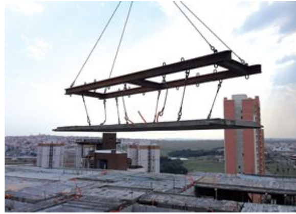
Uso de lajes e outros elementos pré-fabricados pode agilizar execução da estrutura
