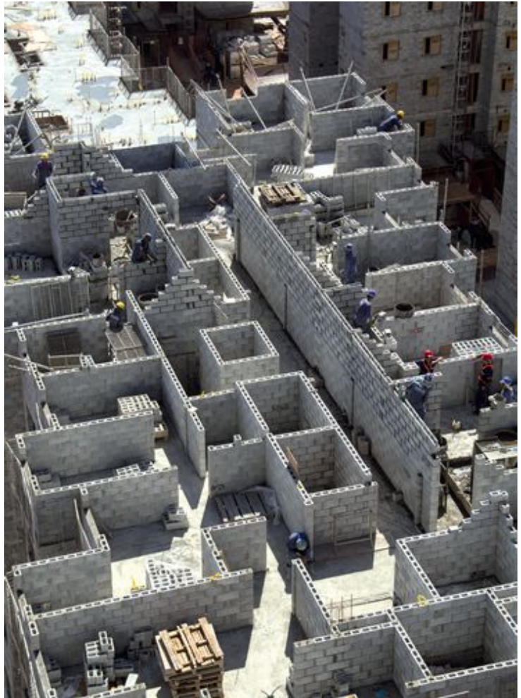
Microplanejamento dos serviços permite distribuir de forma otimizada as equipes de trabalho no pavimento e alocar o material necessário o mais próximo possível do serviço executado
