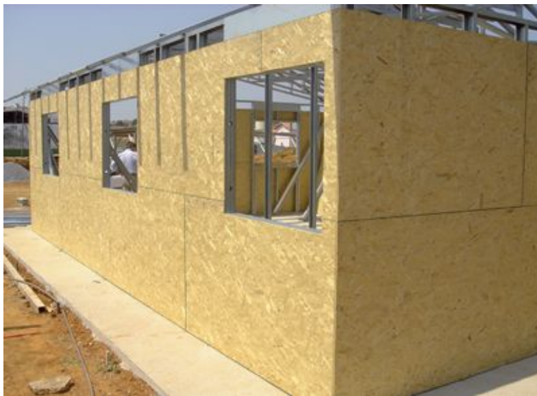
Chapas de OSB fixadas na face externa da estrutura
