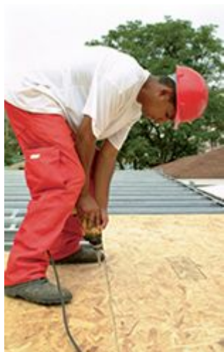
Fixação das chapas de OSB
