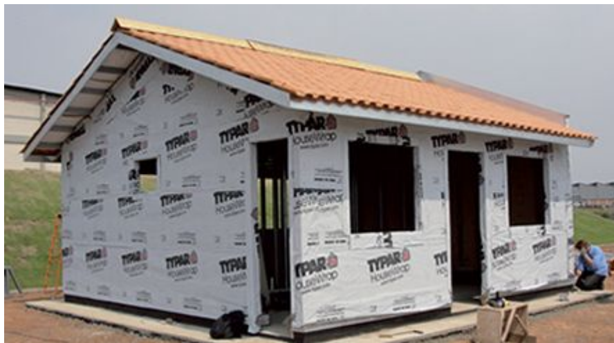
Fixação da barreira impermeável na face externa
