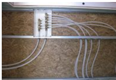
Execução das tubulações hidráulicas com PEX
