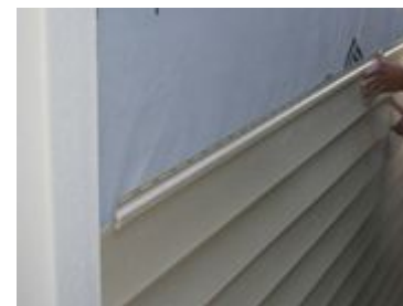
Posicionamento e fixação do siding vinílico
