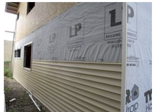
Chapas de OSB, barreira impermeável e siding vinílico
