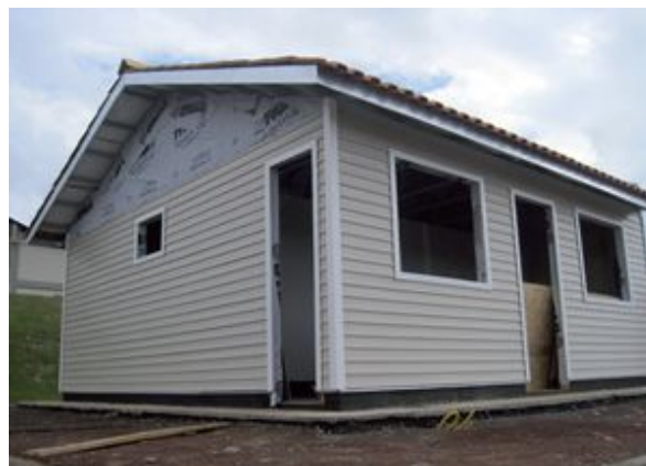
Posicionamento e fixação do siding vinílico
