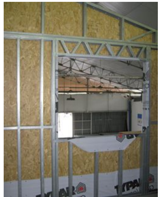
Vista interna de vão da janela com barreira impermeável
