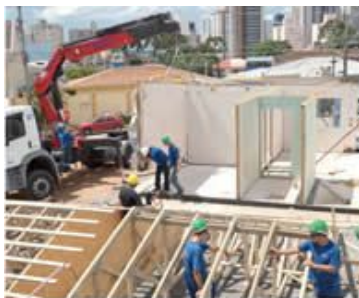
Figura 3 – Transporte, içamento e posicionamento dos painéis são feitos com caminhões munck
