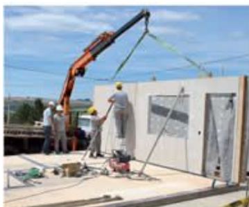
Figura 6 – Paredes são alinhadas conforme marcação executada no contrapiso
