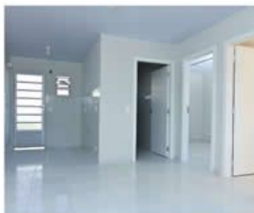
Figura 7 – Áreas molhadas e molháveis recebem impermeabilização e revestimento cerâmico
