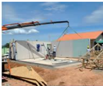
Figura 4 – Painéis já prontos são posicionados sobre os elementos de fundação
