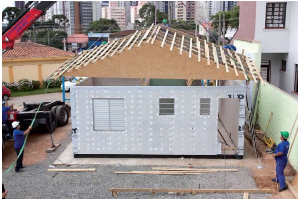
Figura 15 – Içamento e posicionamento da cobertura em madeira
