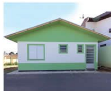
Figura 8 – Paredes externas recebem arremates, como pingadeiras e cantoneiras metálicas
