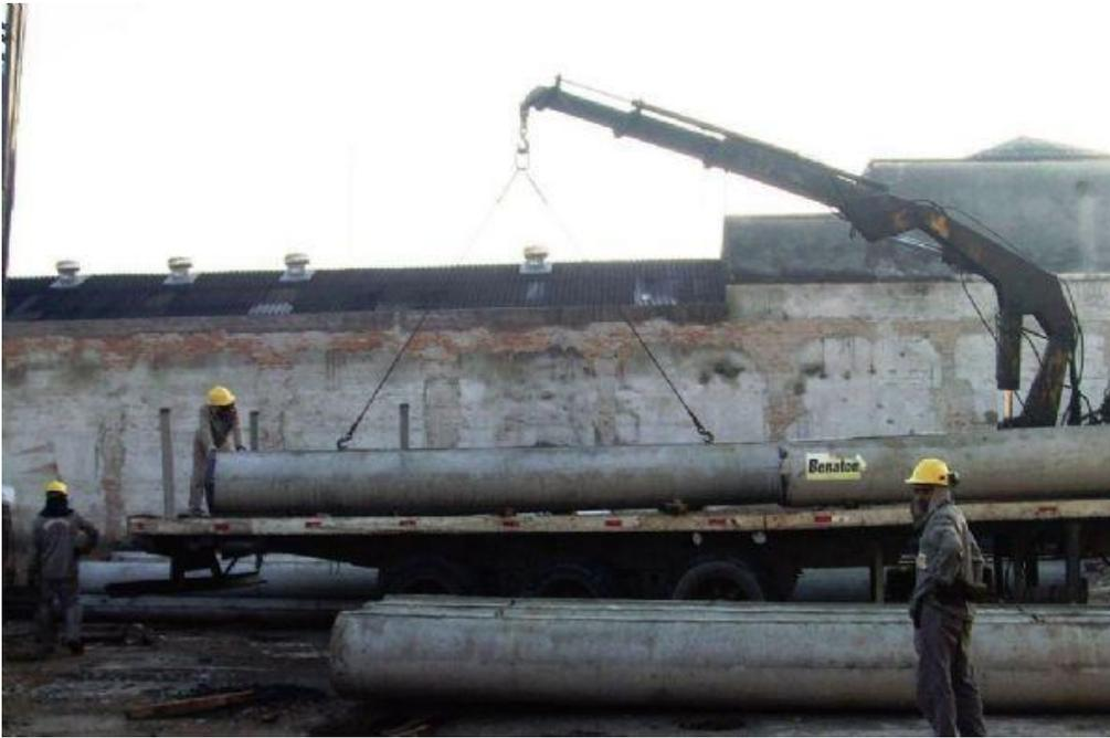
A movimentação das estacas, incluindo o descarregamento, pode ser feita por guindaste. Nesse caso, o apoio deve ser duplo para que a estaca seja transportada na horizontal
