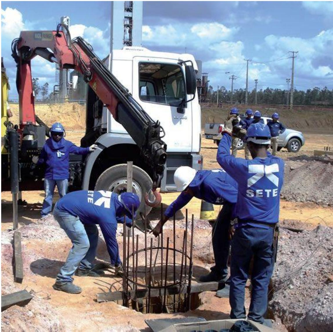
Inserção da armadura e armação montada na base do tubulão
