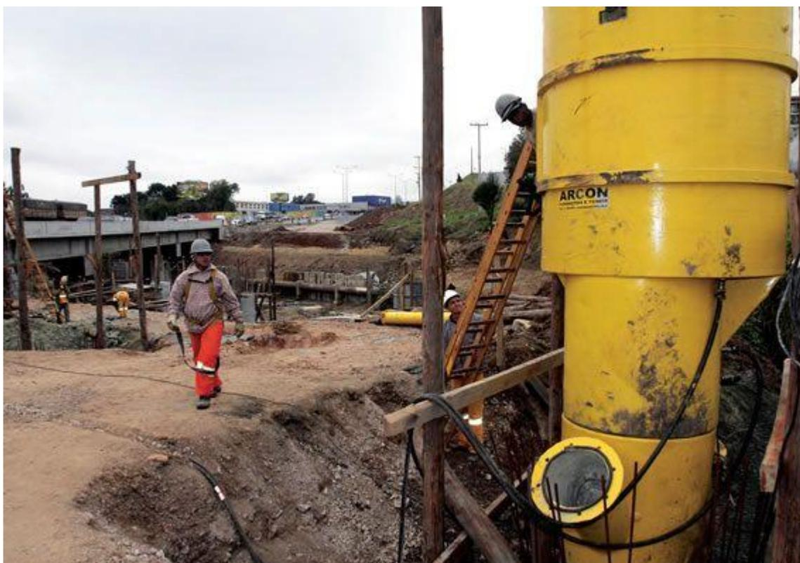
Tubulões a ar comprimido usados na construção dos pilares de sustentação de duas pontes da Linha Verde, em Curitiba
