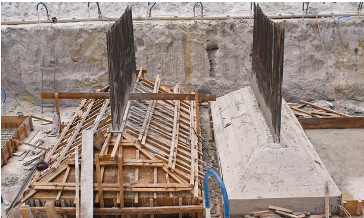
Fundações rasas como as sapatas se caracterizam quando a camada de suporte está a até 2 m de profundidade da superfície
