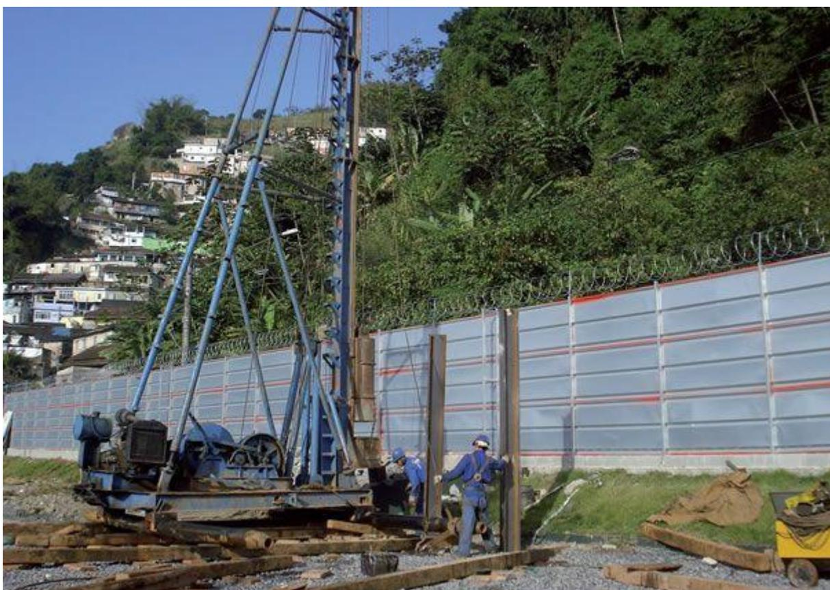
Possibilidade de emendas das estacas metálicas permite o alcance de profundidade de quase 100 m
