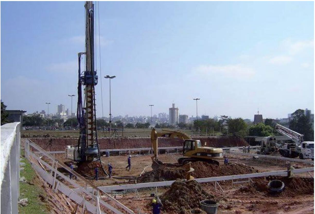
A hélice contínua é uma das soluções preferidas quando as condições topográficas e geotécnicas são favoráveis
