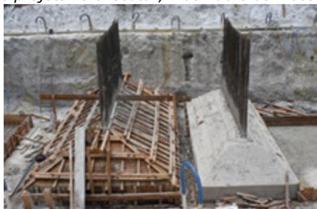
Apoiados a pequenas profundidades em relação ao nível do solo, certos tipos de fundação requerem pouca escavação e consumo moderado de concreto para execução das peças. Apesar disso ? a suposta simplicidade dos blocos e **sapatas** ? é preciso cuidado ao projetar e executar esses elementos que são a base da estrutura.
