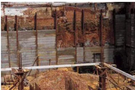
Sem Talude: Obra com cortina pré-moldada, em que foram escavados 7 m de argila siltosa com água. Por ser um terreno muito ruim, foi necessário eliminar o talude. Assim, sobra mais espaço para a execução das fundações próximas à periferia
