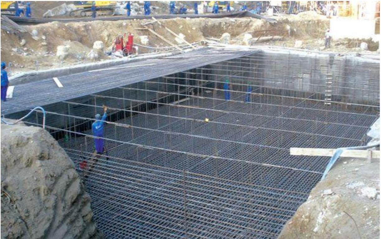
Detalhe da montagem da armadura de um bloco de grandes dimensões
