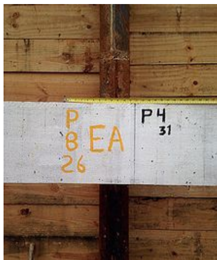
Figura 3 - Detalhe de gabarito de madeira para locação de obra (tábua pintada de branco e identificações em preto e amarelo)
