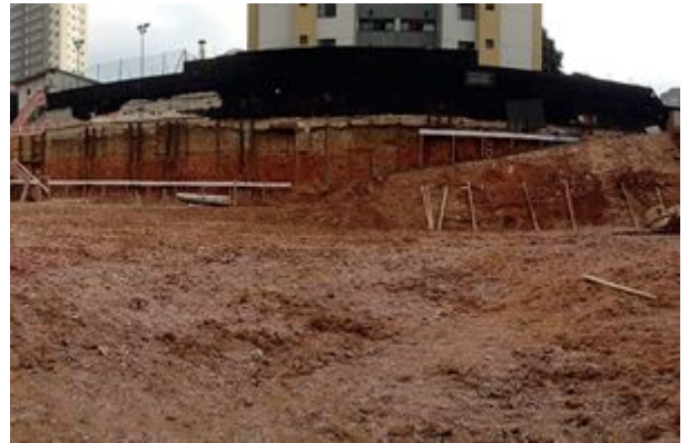
Figura 5 - Gabarito escalonado devido ao desnível do terreno
