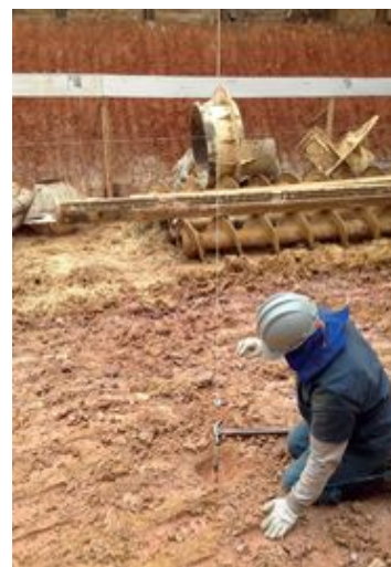
Figura 4 - Locação de estaca no terreno
