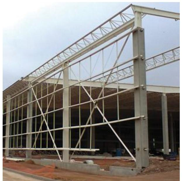
**Estrutura e fechamentos pré-fabricados aceleraram o processo da obra, que dispensou sistemas moldados in loco**
