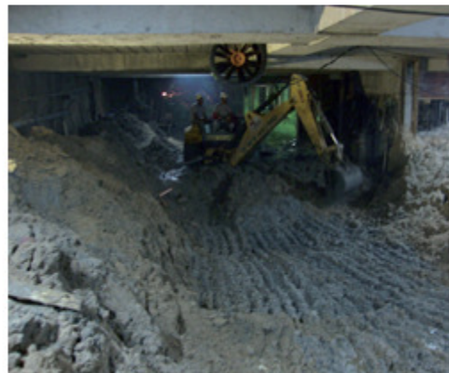
A escavação era confinada, feita com equipamentos relativamente pequenos e debaixo de cada laje, uma por vez
