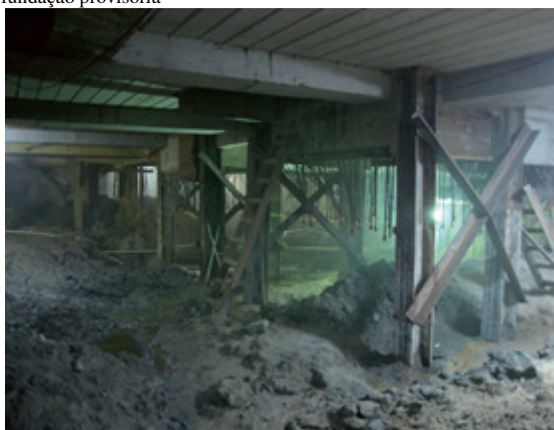
A estrutura provisória foi feita com perfis metálicos e lajes pré-moldadas
