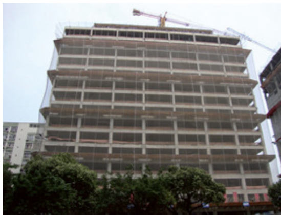
A todo momento da execução, era necessário verificar se o incremento das cargas estava de acordo com a capacidade da fundação provisória
