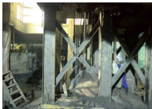
Os perfis metálicos se dividiram entre provisórios e incorporados aos pilares definitivos, cravados em barretes
