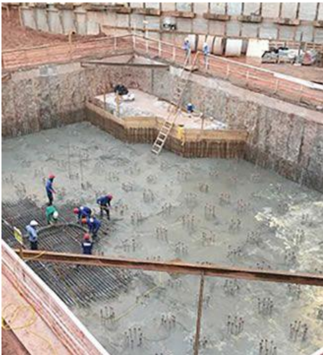
Concretagem da primeira camada do Radier estaqueado R5
