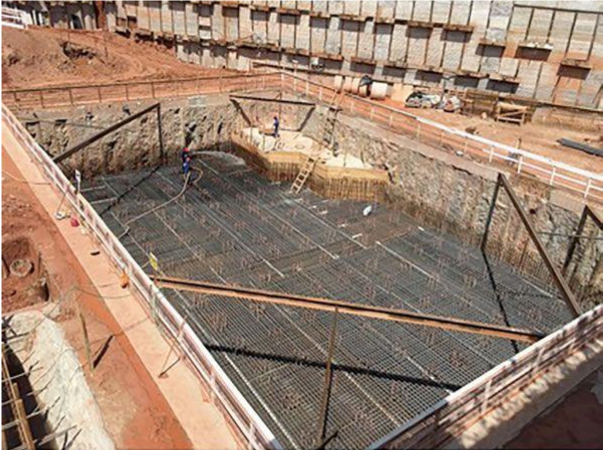
Radier estaqueado R5 (Volume = 855 m 3 ) sobre 195 estacas (Ø 60 cm) com 22,6 m de profundidade
