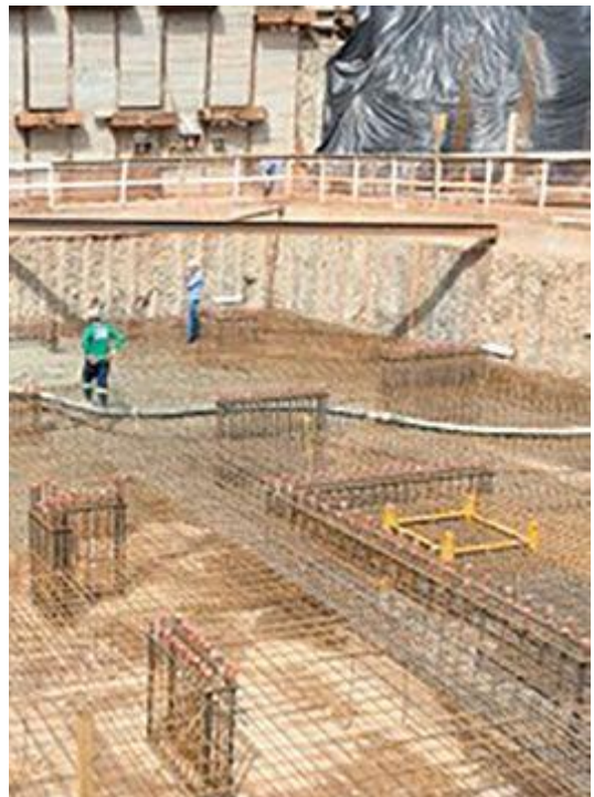
Concretagem da última camada do Radier estaqueado R5
