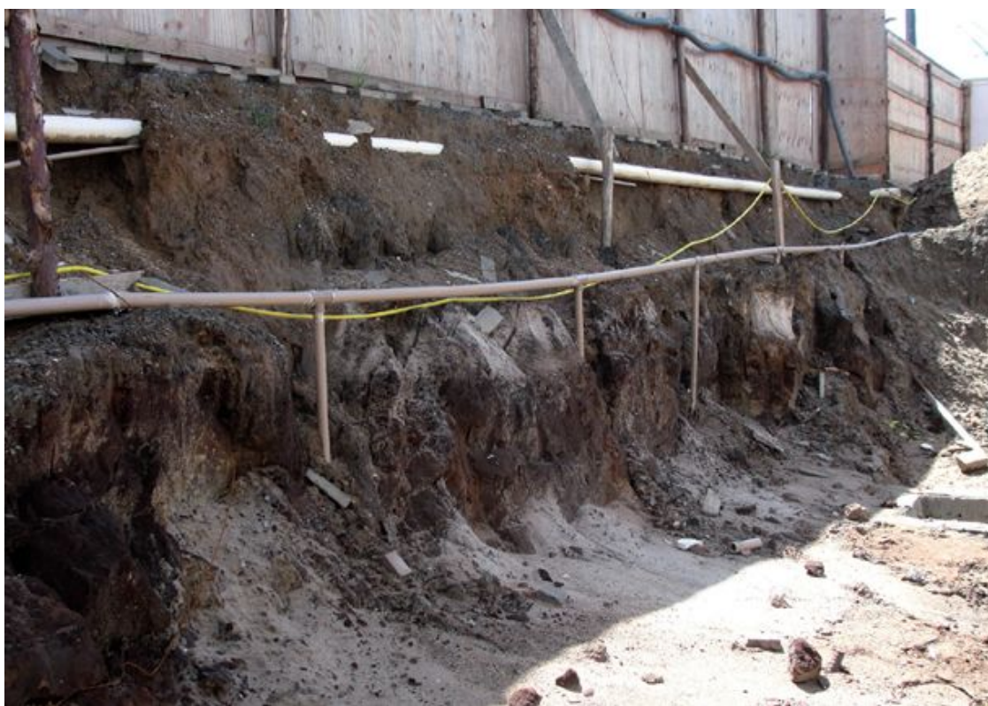
Figura 3 - Detalhe dos componentes expostos do sistema de ponteiros filtrantes
