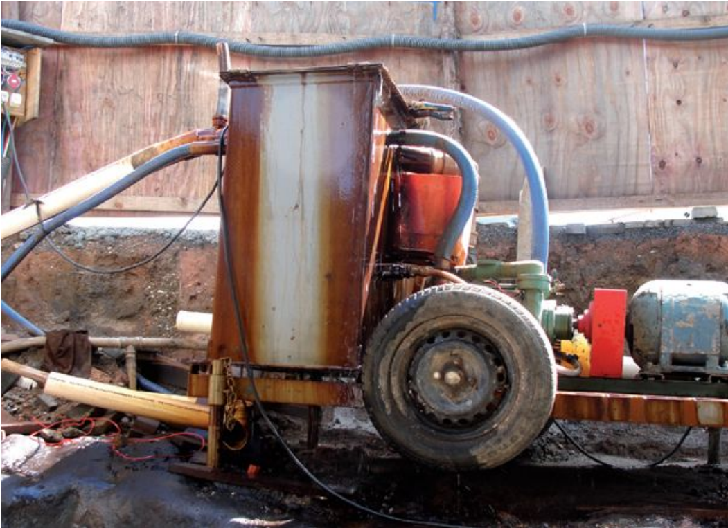
Figura 4 - Uma vez instalado, equipamento de bombeamento para o rebaixamento do lençol freático funcionará sem interrupção até o término do serviço
