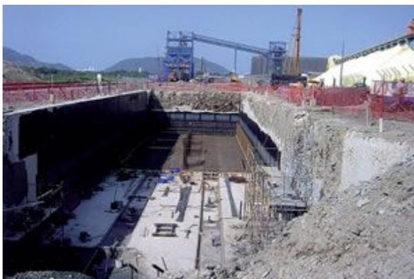
armazéns. A profundidade de escavação das moegas variaram entre 6 m e 10 m de profundidade na argila marinha saturada de SPT 0 a 2. O jet grouting armado com três barras especiais serviram também como elemento de fundação dessas estruturas na condição final
