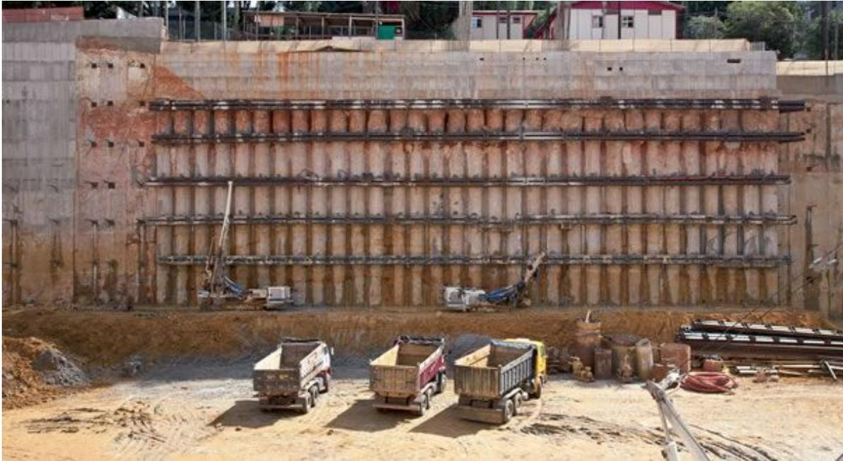
Garantia de resistência, rapidez de execução e versatilidade são algumas das vantagens do jet grouting. A tecnologia permite melhoria e reforço do solo por meio de colunas de solo-cimento executadas com perfuração, jateamento e desagregação do solo com calda de cimento a altas velocidades (da ordem de 800 km/h) e grandes impactos. Aplicáveis a qualquer tipo de solo, sem restrições granulométricas, as colunas de jet grouting podem ser feitas em quaisquer direções.
