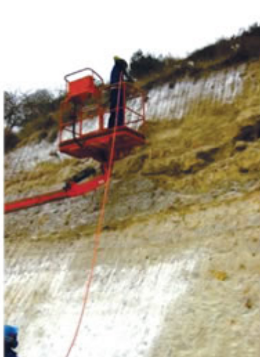
Foto 12 - Cabine elevada permitindo pintura direta em alturas maiores
