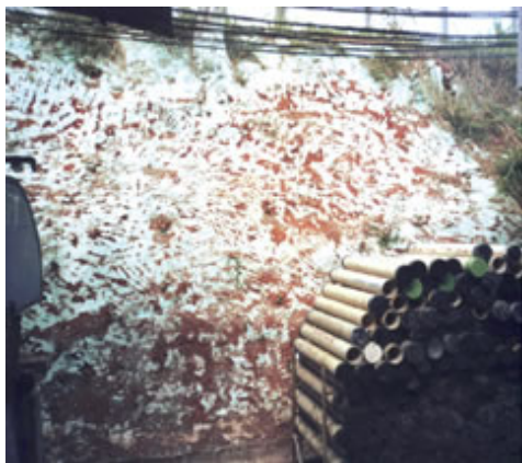
Foto 5 - Talude com a proteção escarificada com ancinho de mão
