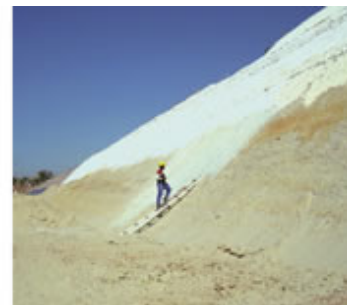
Foto 4 - Talude sendo protegido concomitantemente com a terraplenagem
