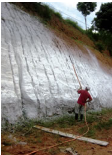
Foto 11 - A lança presa em uma haste de madeira leve como expediente para se atingir alturas maiores. Mangueira de 30 m permitindo longo raio de alcance
