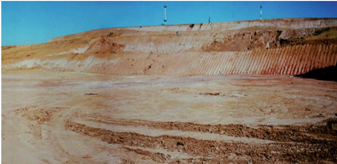
Foto 1 - Cena comum propiciada por uma cultura técnica lamentavelmente equivocada: grandes terraplenos francamente expostos a processos erosivos por um longo tempo, quando o correto seria ou prescindir de tão extensas terraplenagens ou já proteger os taludes concomitantemente com o avanço da terraplenagem
