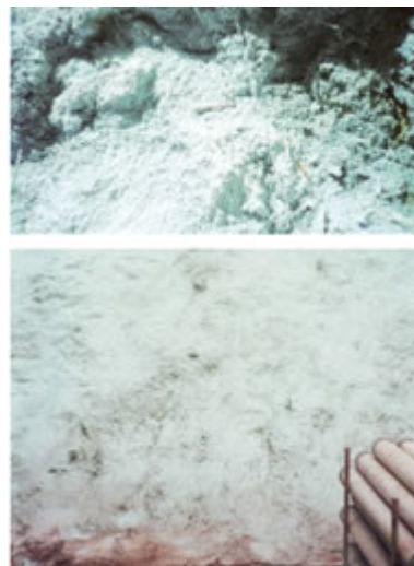
Foto 13 - Reentrâncias devidamente protegidas
