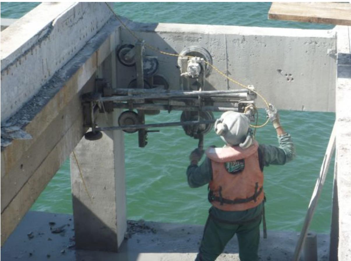
Figura 6 - Máquina de corte montada na posição horizontal e passagem dos fios nas polias para o corte de uma viga de concreto
