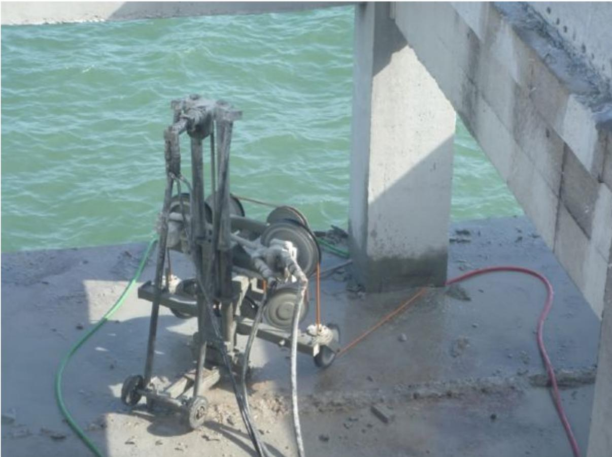
**Figura 7** - Máquina de corte montada na posição vertical e corte de um pilar de concreto armado
