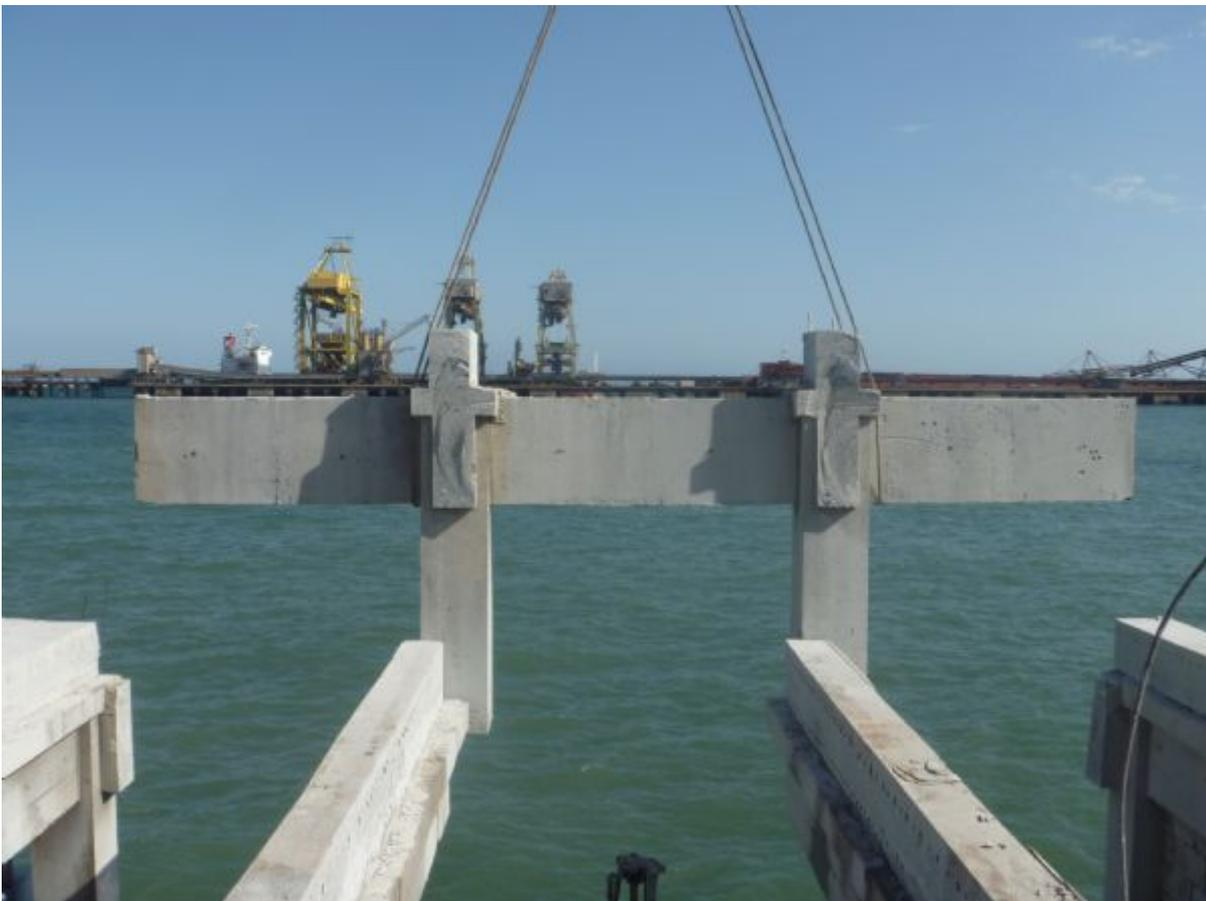
**Figura 8** - Estrutura cortada com fios diamantados sendo içada e retirada do local dos serviços
