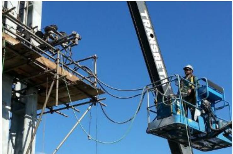
Figura 1 - Detalhe da instalação do fio diamantado em uma obra de demolição
