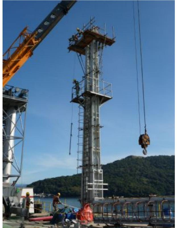
**Figura 2** - Retirada de parte da estrutura de uma torre metálica de iluminação em Angra dos Reis (RJ)
