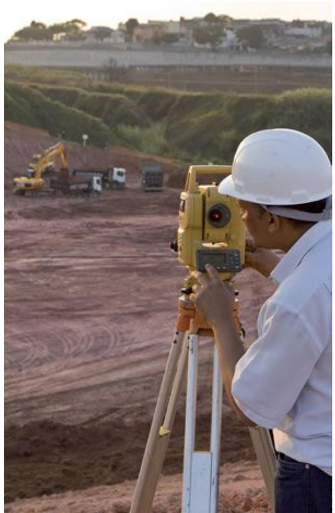
Levantamento topográfico gera informações que servirão de referência para outros profissionais, indicando onde devem ser feitas obras de terraplenagem, fundações, paredes, etc.
