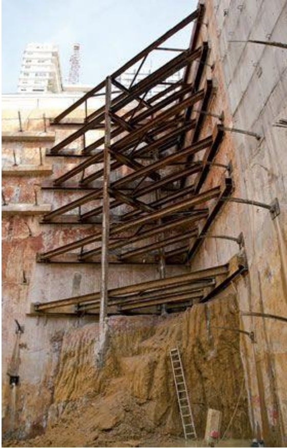
Travamentos metálicos provisórios executados nas extremidades das paredes de contenção da Avenida Paulista
