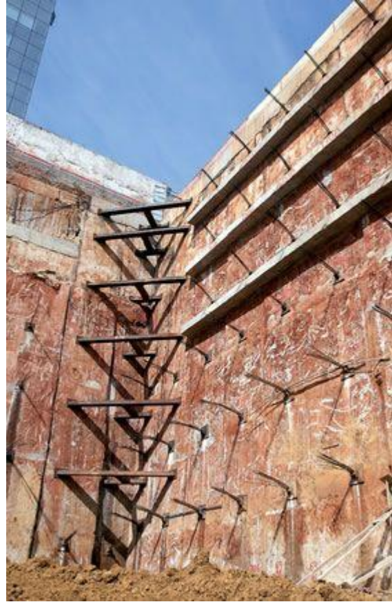
Travamentos metálicos provisórios executados nas extremidades das paredes de contenção da Avenida Paulista
