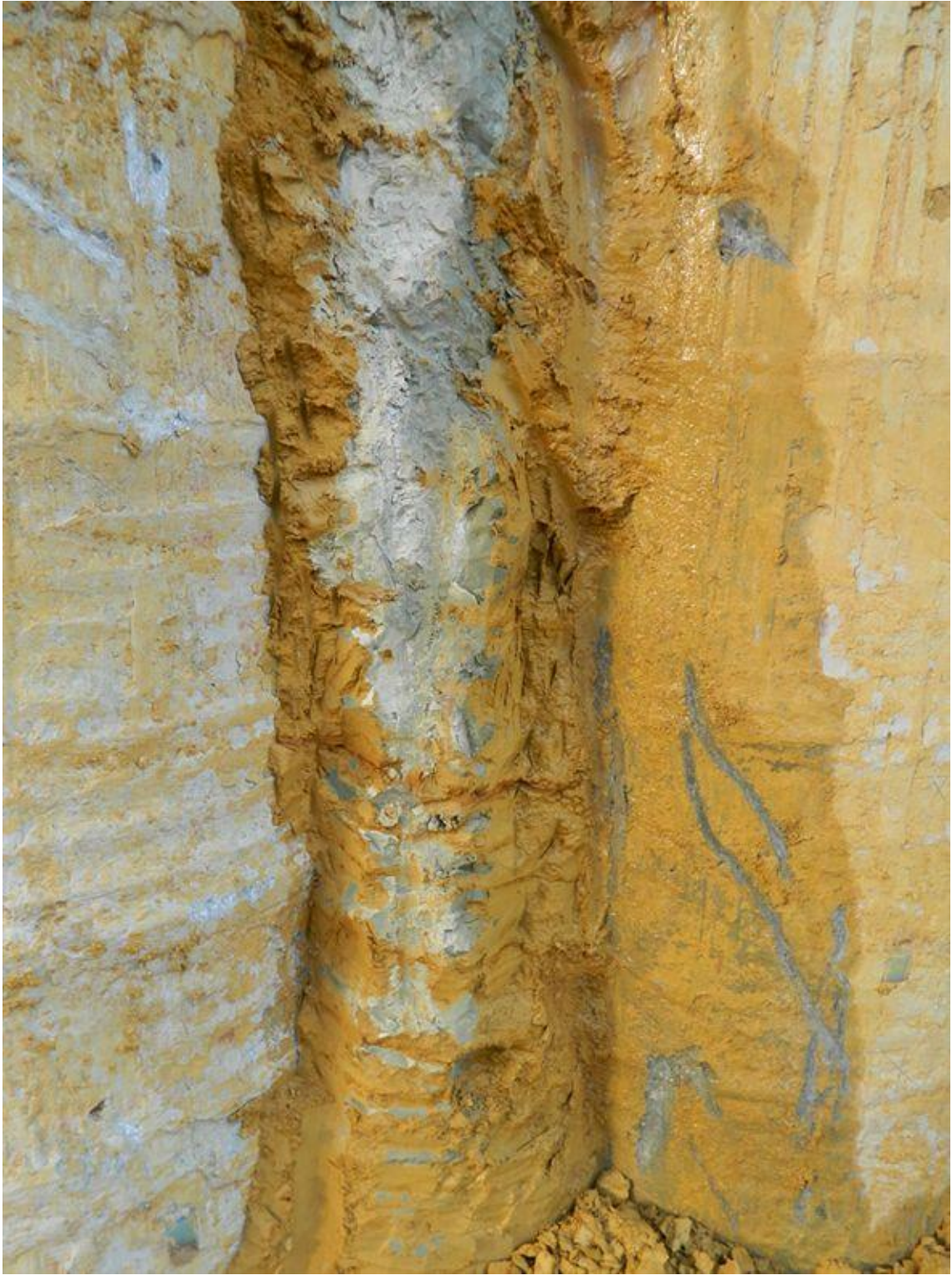
Detalhe de uma coluna de solo-cimento do tipo Chemical Churning Pile (CCP)
