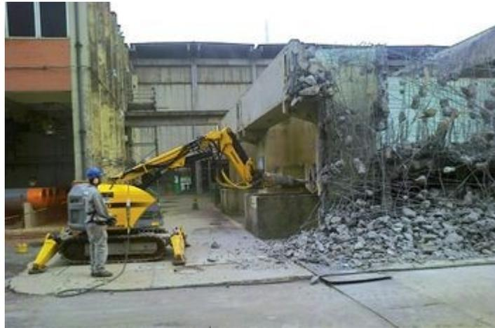
Figura 6- Demolição controlada de estrutura de concreto com robô operado via cabo
