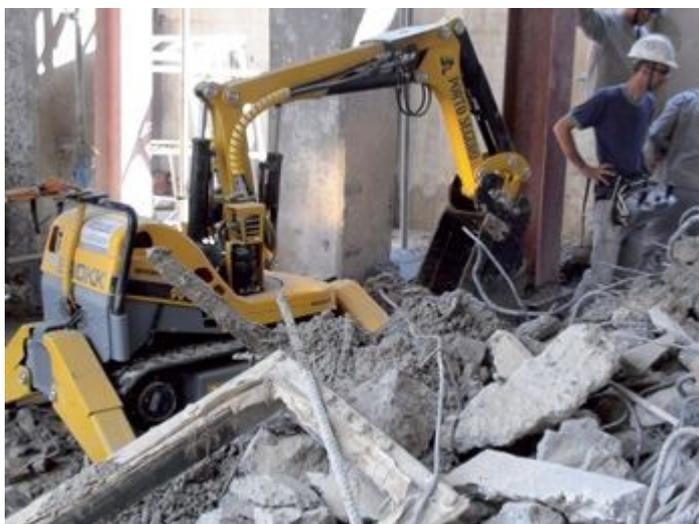
Figura 5 - Robô equipado com concha
