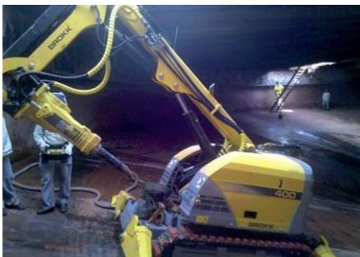
Figura 4 - Robô também pode fazer demolição com um rompedor
