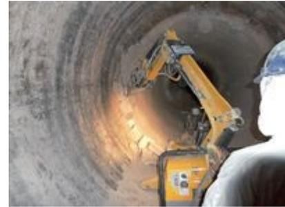
Figura 9 - Robô usado na demolição de túnel de co
