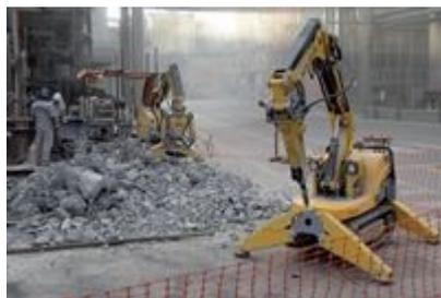
Figura 8 - A demarcação da área, seja com barreira sinalizadora ou mecânica, deve anteceder o início dos trabalhos
