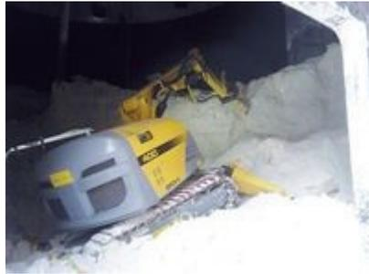
Figura 7 - Robô pode ser usado em áreas confinadas
