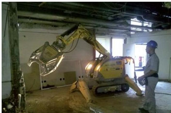
**Figura 3-** Os robôs podem ser utilizados com diferentes ferramentas. Neste caso, o robô usa uma mandíbula
