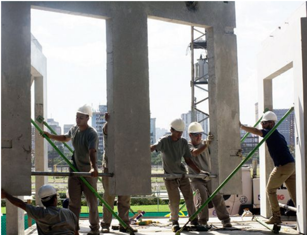
Posicionamento de painel de porta e janela
