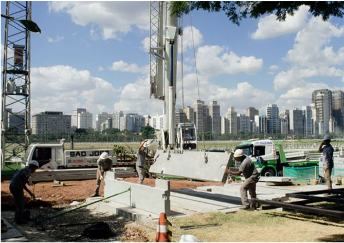
Descida dos painéis de fechamento
