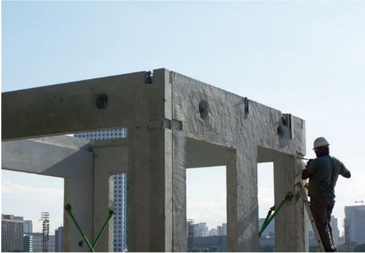
União dos painéis por aparafusamento
