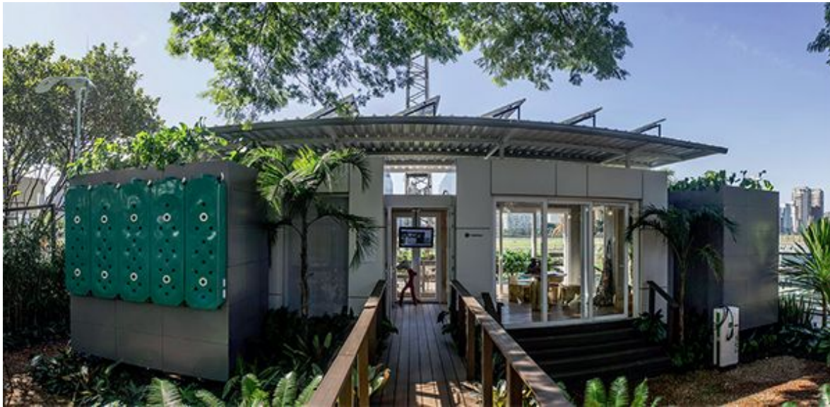
Vista frontal, com destaque para a fachada ventilada de placas cerâmicas e as cisternas para armazenamento de águas pluviais
