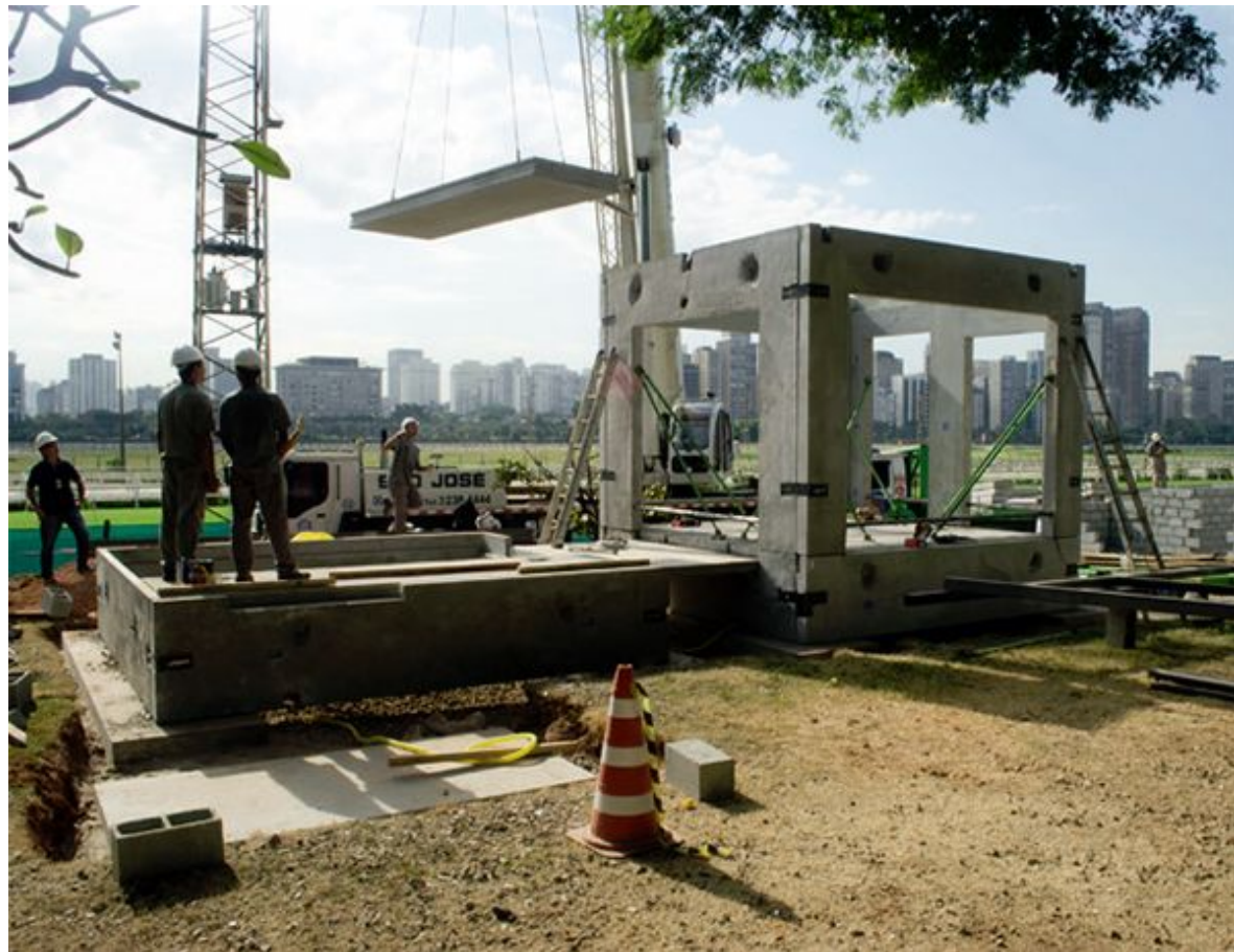
Descida dos painéis de fechamento
