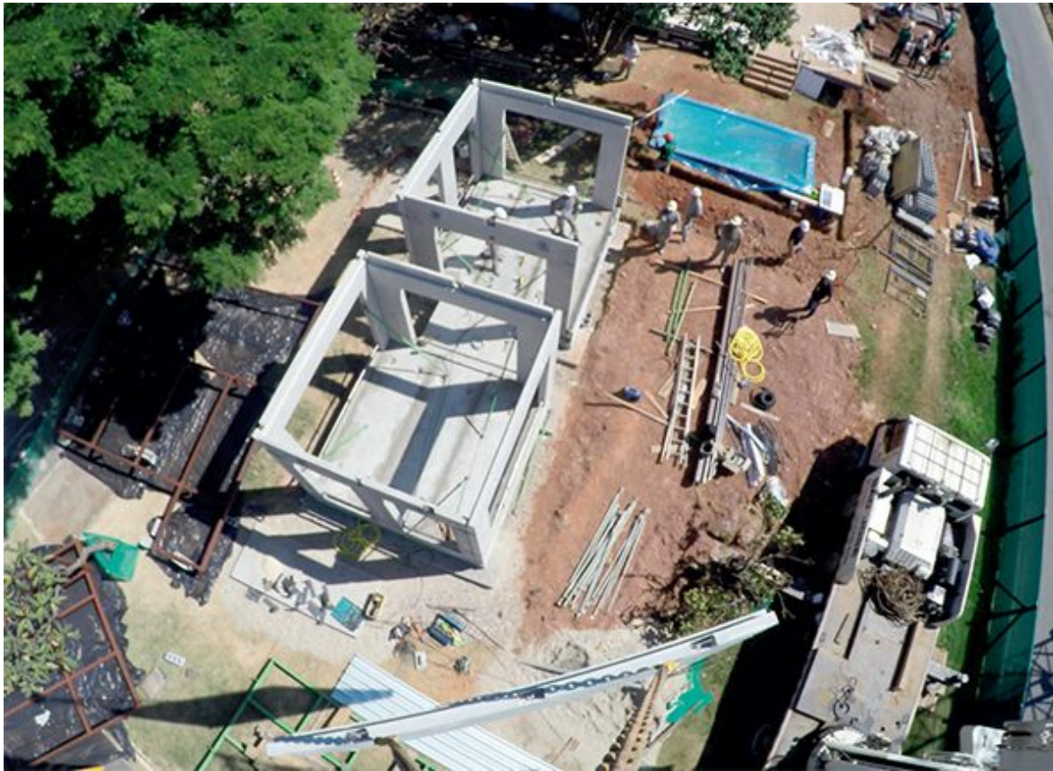
Canteiro transformado em pátio de montagem da unidade
