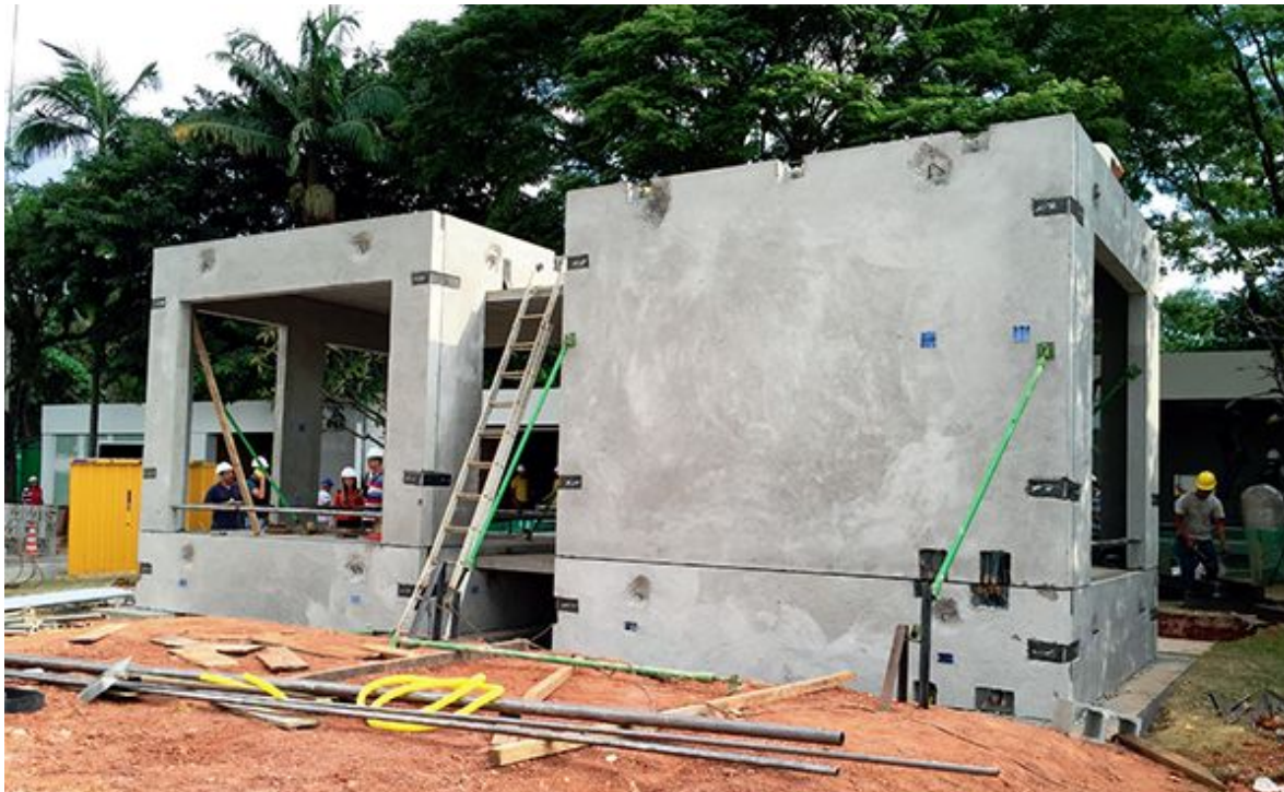
As placas estruturais, embora feitas em concreto maciço, são mais leves devido à incorporação de argila expandida no lugar de agregado graúdo
