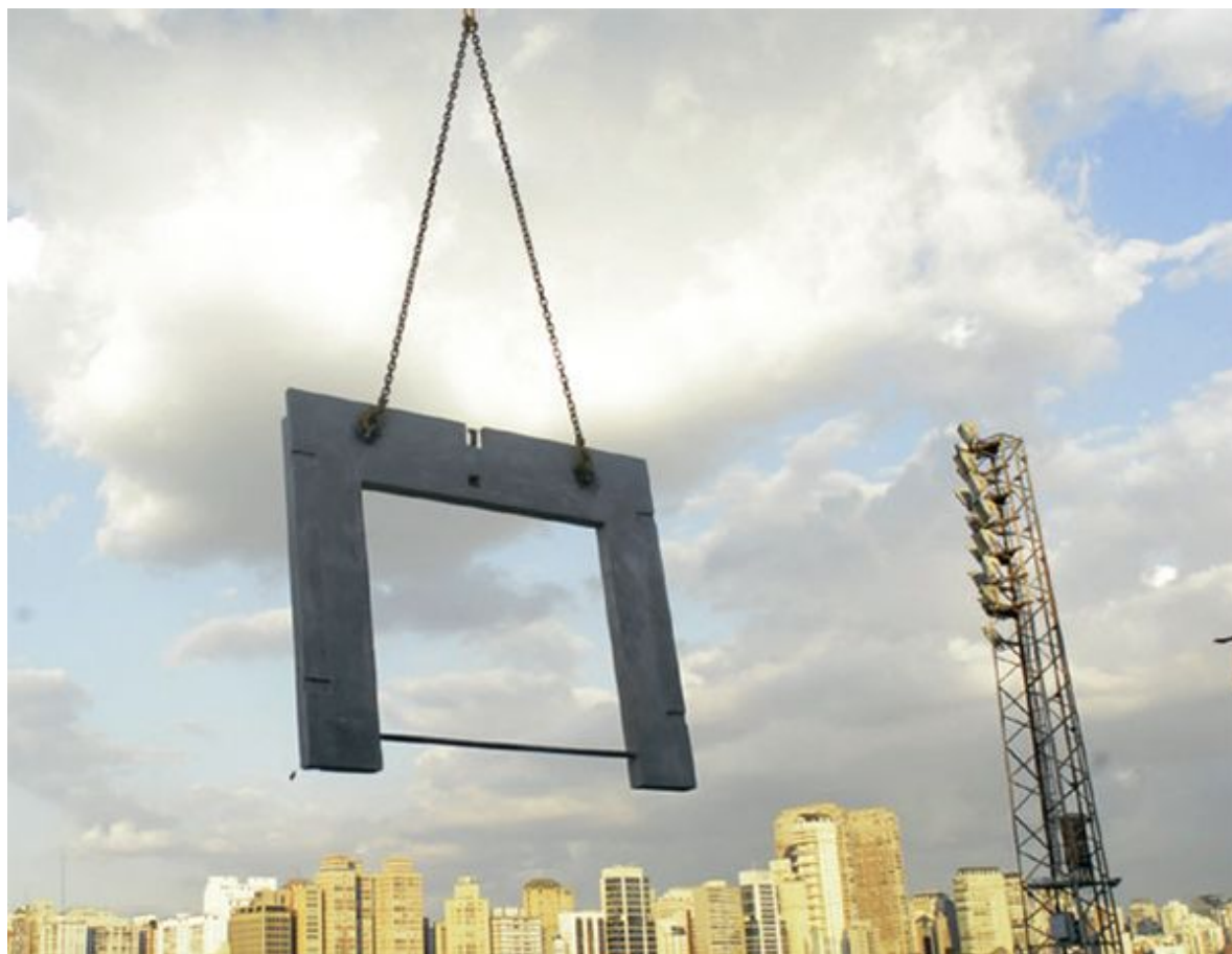
Içamento de painel de porta-balcão
