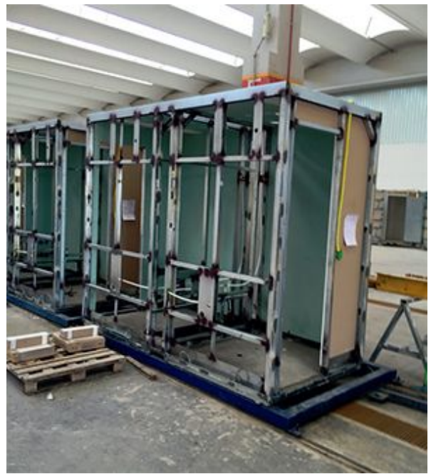
Anexo ao módulo composto de placas de concreto integra-se outro módulo, este para a cozinha, em steel frame, igualmente industrializado
