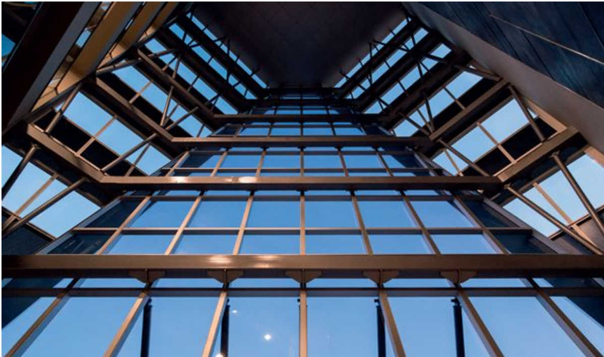
O projeto do arquiteto Ronaldo Rezende previu que o átrio formado no vértice do edifício fosse envolvido pelas fachadas laterais, que convergem até quase se tocarem na porção mais alta, formando, de cada lado, um triângulo invertido
