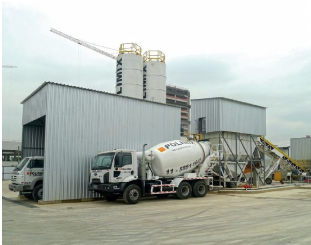
Central de concreto instalada na obra fornecerá 186 mil m 3 de concreto para todo empreendimento
