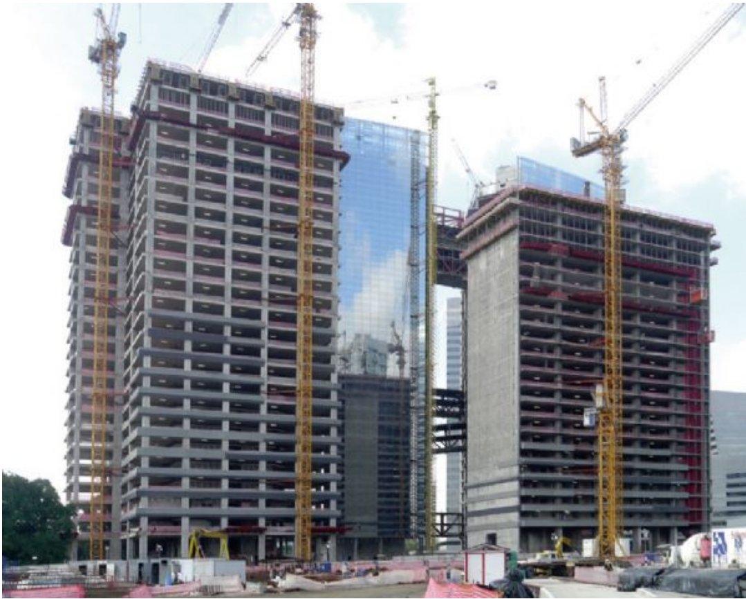
Industrializar ao máximo a execução das obras dos edifícios comercial e corporativo era uma das metas para o empreendimento
