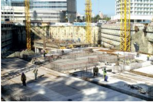
A adoção das lajes alveolares pré-moldadas protendidas permitiu agilizar a execução da torre corporativa
