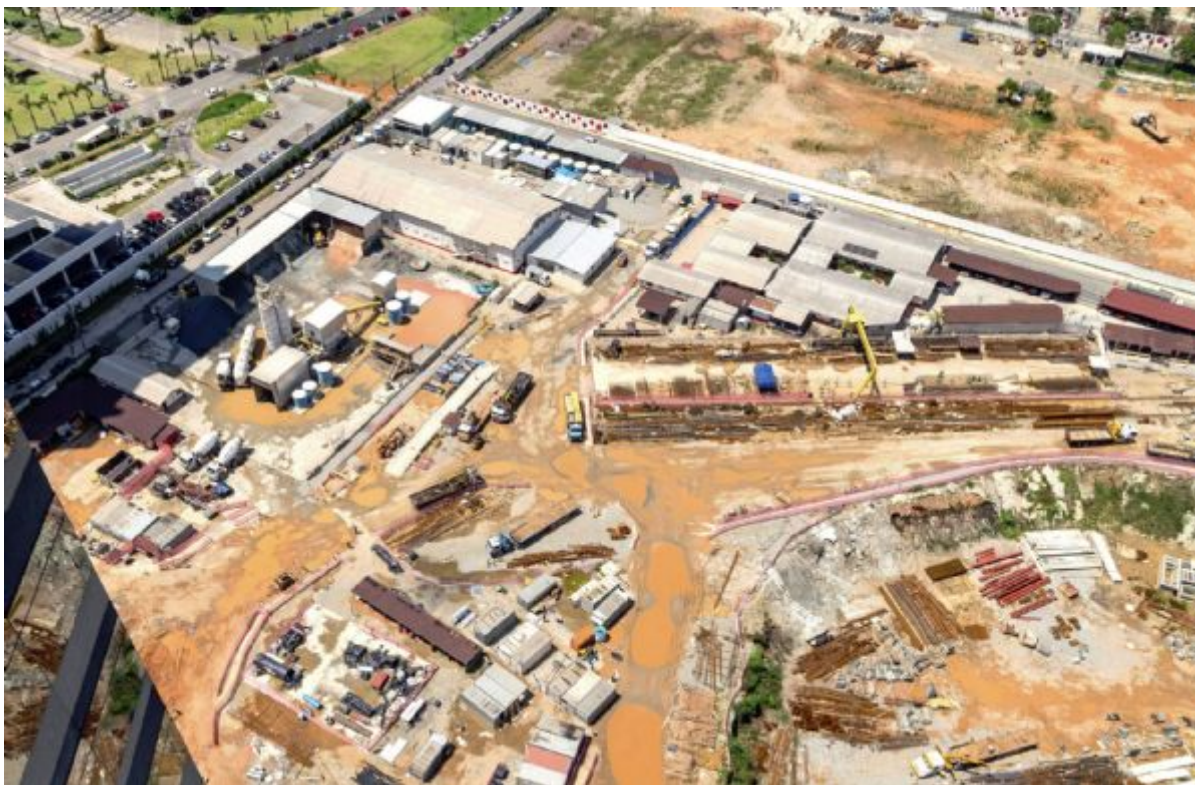
Do ponto de vista da logística de produção, cada gleba foi tratada como uma grande obra. No entanto, a equipe de planejamento levou em conta as necessidades do conjunto do empreendimento, criando circulações dentro do canteiro que pudessem servir a mais de uma gleba
